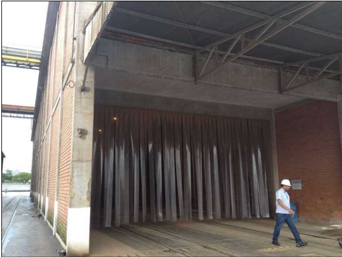
Figura 54. Controle adotado nas moegas
