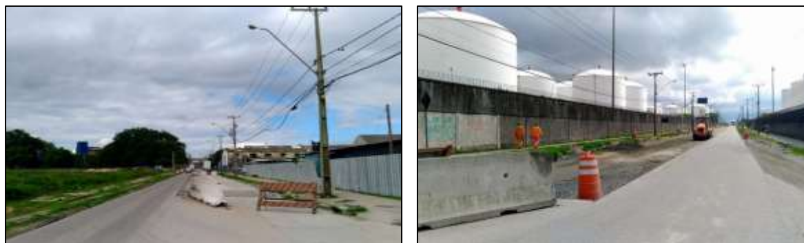
Figura 41. Trechos da Avenida Bento Rocha em manutenção
