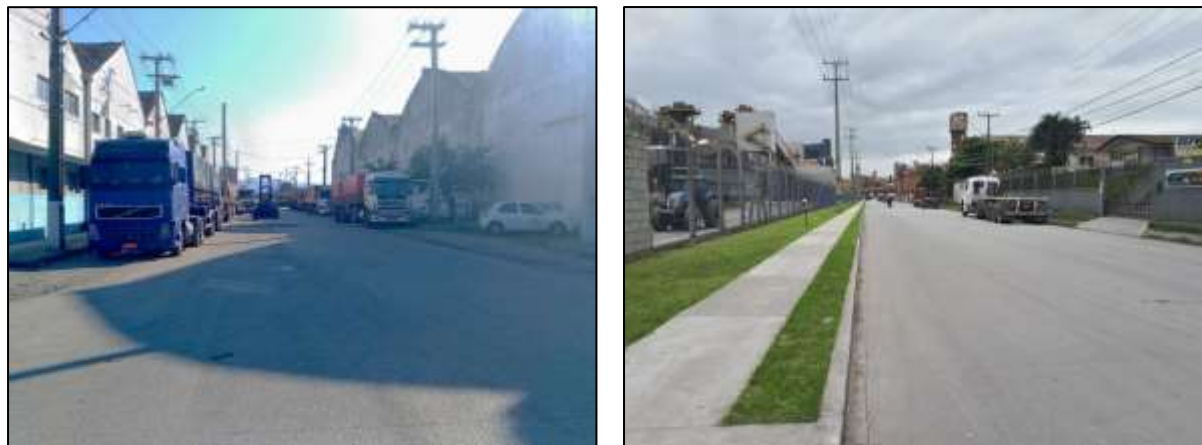
Figura 43. Condições da Rua Barão do Rio Branco
