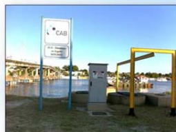
Elevatória de Esgoto Mercado
