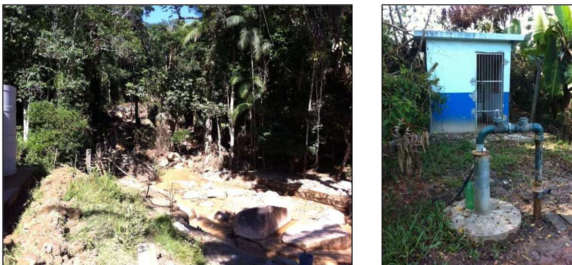
Figura 5.20 - Captações de água bruta.
