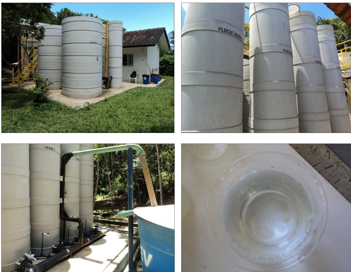
Figura 5.26 – Decantadores, floculadores, filtros e água pós-tratamento.
