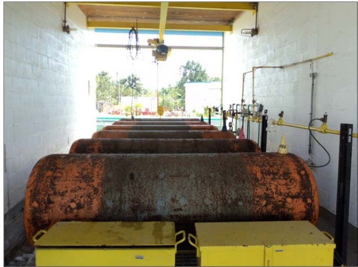
Figura 5.41 - Reservatório de sulfato de alumínio e cilindro de cloro gasoso.
