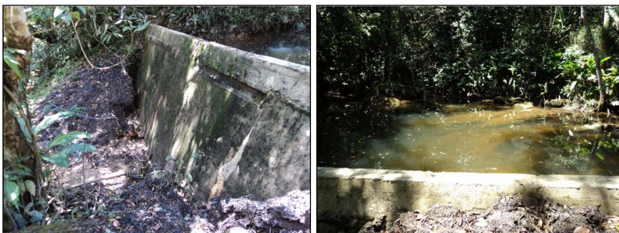
Figura 5.24 - Captação de água bruta – manancial superficial.
