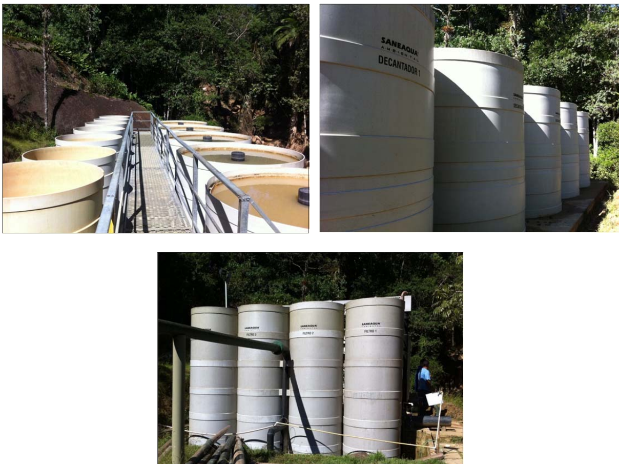
Figura 5.21 – Decantadores e filtros.
