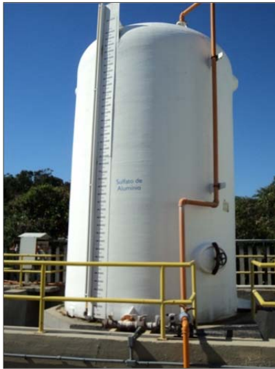
Figura 5.41 - Reservatório de sulfato de alumínio e cilindro de cloro gasoso.
