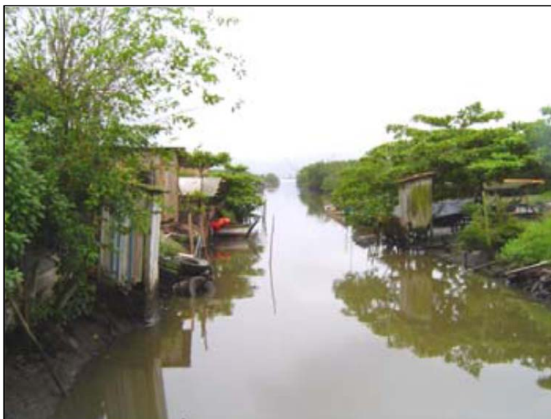
Figura 5.16 - Ocupação irregular no canal da Anhaia.
