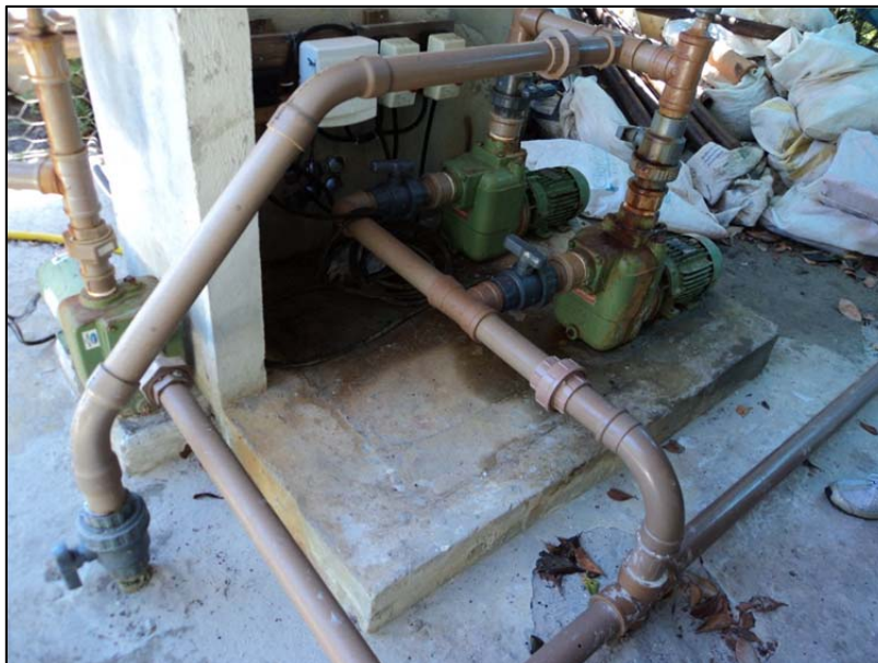
Figura 5.29 - Captação de água bruta – manancial subterrâneo.
