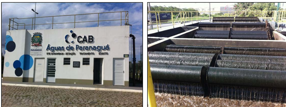
Figura 5.60 - Fachada da ETE e reator biológico (lodo ativado).
