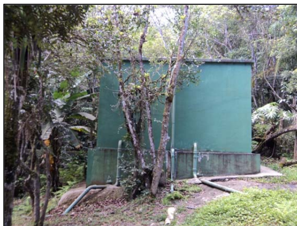
Figura 5.27 – Reservatórios de água tratada.
