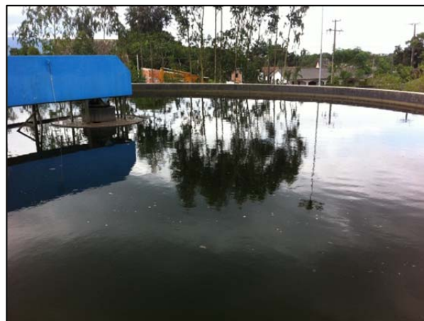
Figura 5.54 - Reator biológico (lodo ativado) e decantador secundário.
