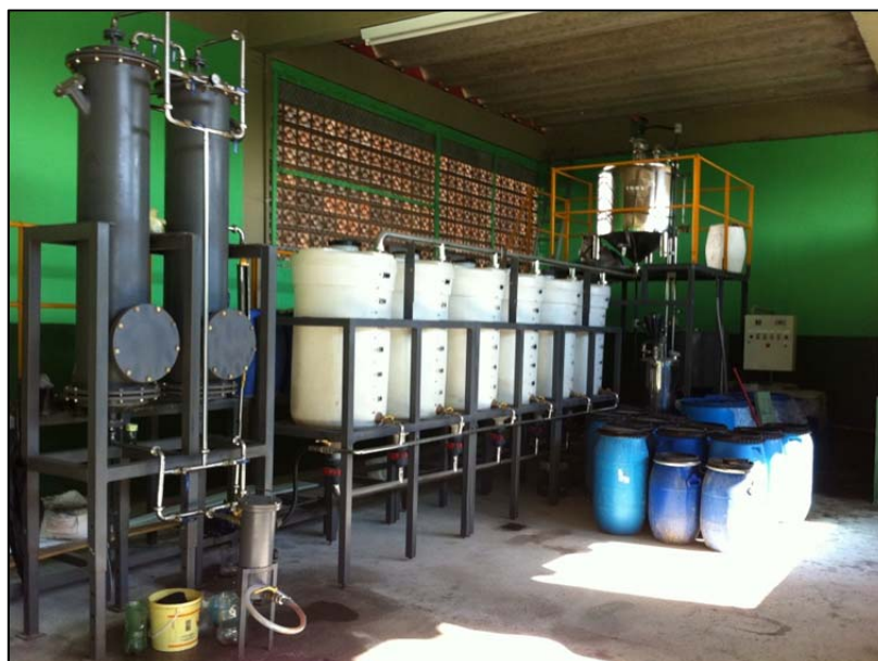
Figura 5.70 - Usina de fabricação de biodiesel.
