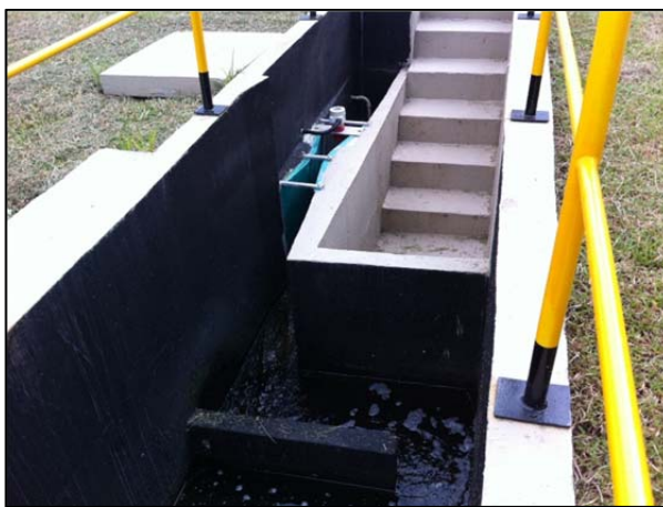
Figura 5.58 - Reator biológico (lodo ativado) e saída do tratamento.
