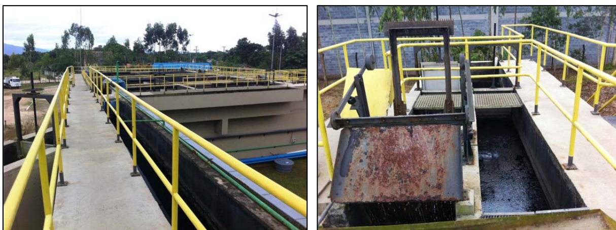
Figura 5.53 - Unidades da ETE Emboguaçu e tratamento preliminar.
