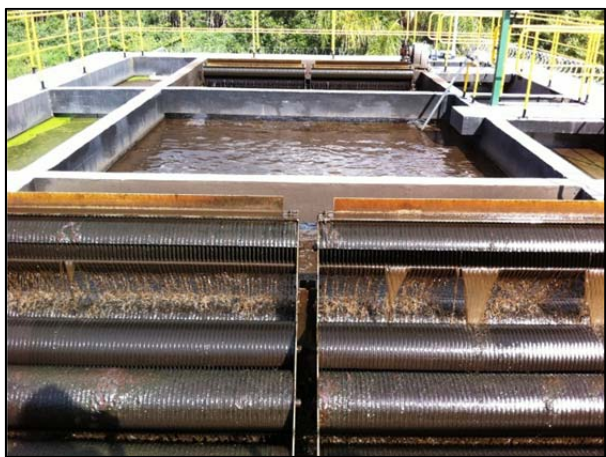
Figura 5.58 - Reator biológico (lodo ativado) e saída do tratamento.
