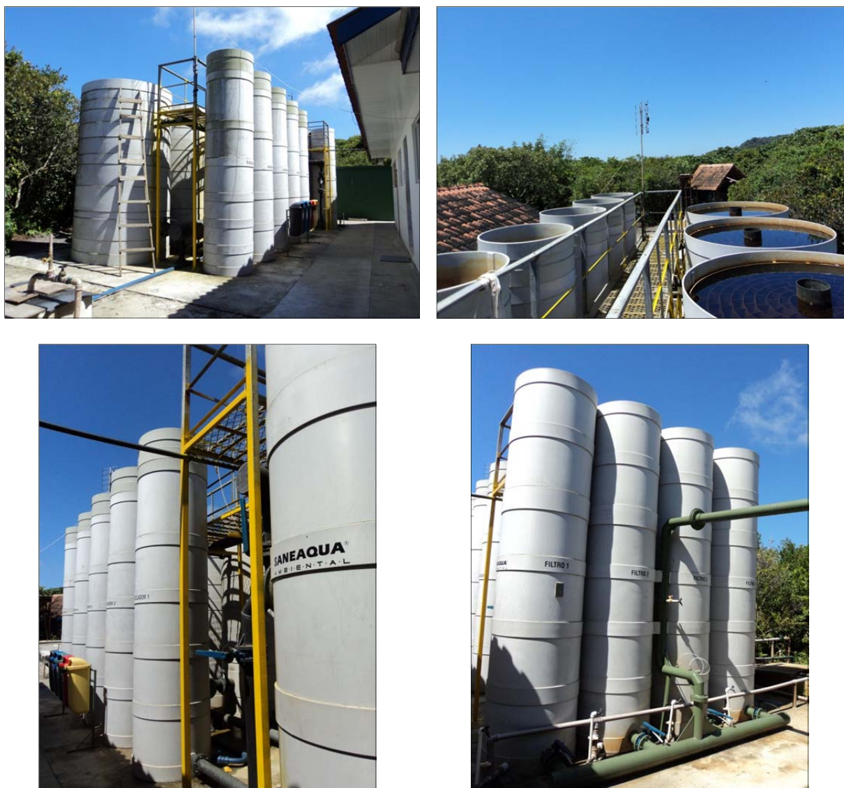
Figura 5.31 – Decantadores, floculadores e filtros.
