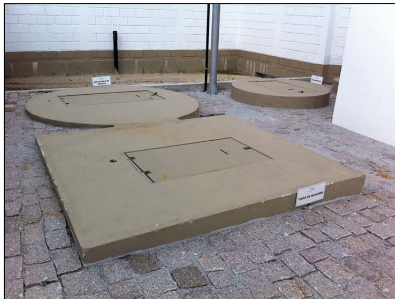
Figura 5.59 - Estação elevatória de esgoto bruto.
