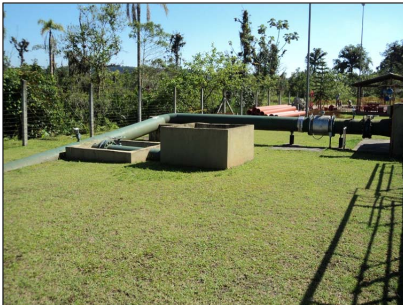
Figura 5.40 - Adutoras de água bruta na entrada da ETA Colônia.
