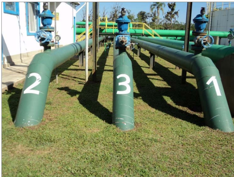
Figura 5.43 - Adutoras de água tratada.
