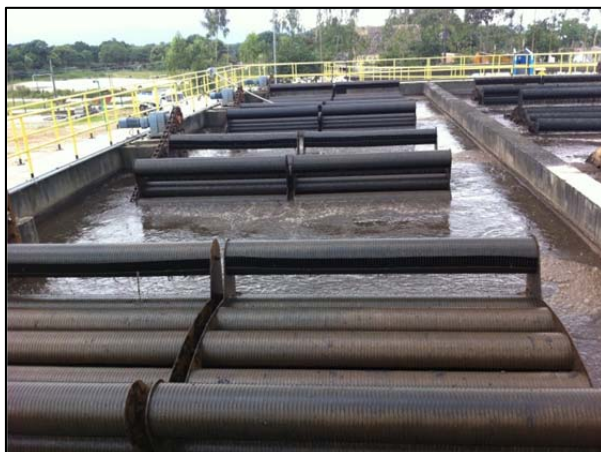
Figura 5.54 - Reator biológico (lodo ativado) e decantador secundário.
