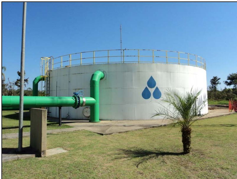
Figura 5.45 – Reservatório de água tratada – ETA Colônia.
