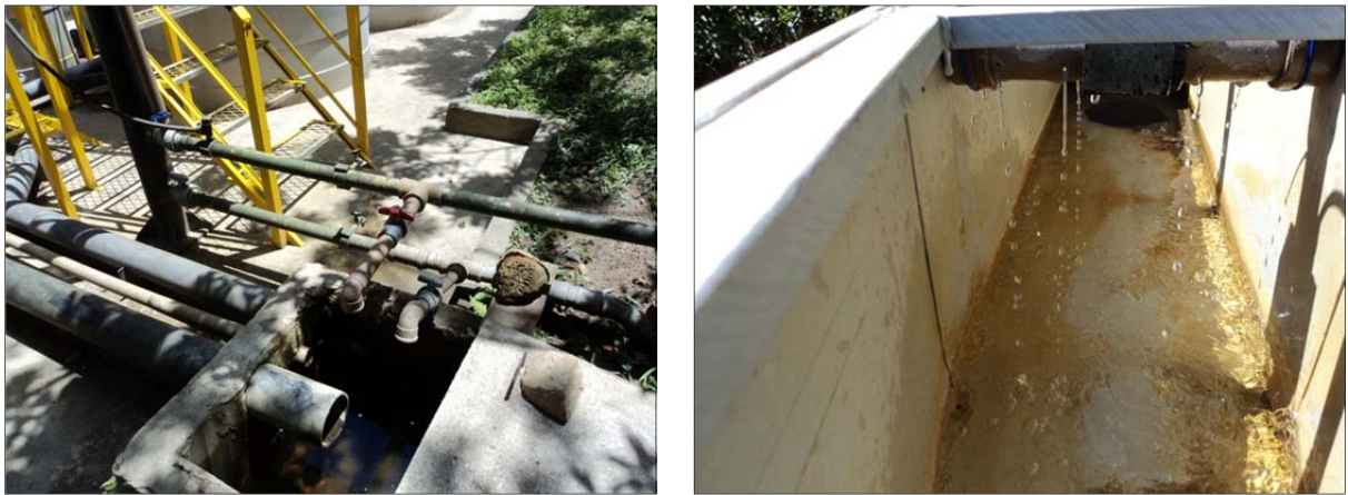
Figura 5.25 – Poço de chegada e calha Parshall.
