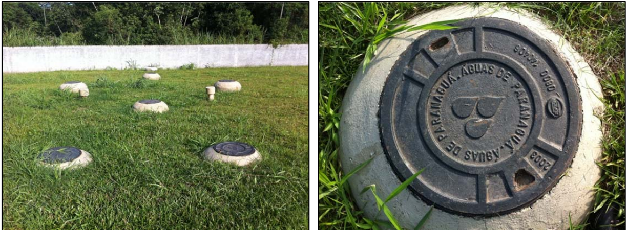
Figura 5.61 - Sistemas individuais de tratamento de esgoto.
