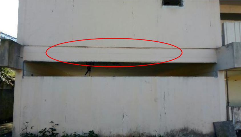
Flexão da viga e fissura entre a viga e a alvenaria. Solução execução de itens 7.7, 7.4 e 7.5.
