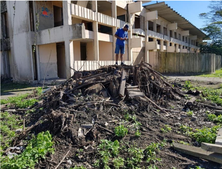
Frente da edificação. Local onde havia uma seringueira. Não há sinais de danos na fundação provocada pela mesma.
