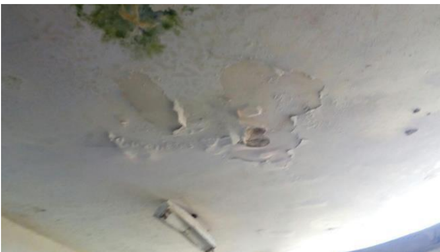
Vigas da Fachada atingida por corrosão da armadura e deslocamentos de concreto. Necessidade de remoção conforme item 7.2.
