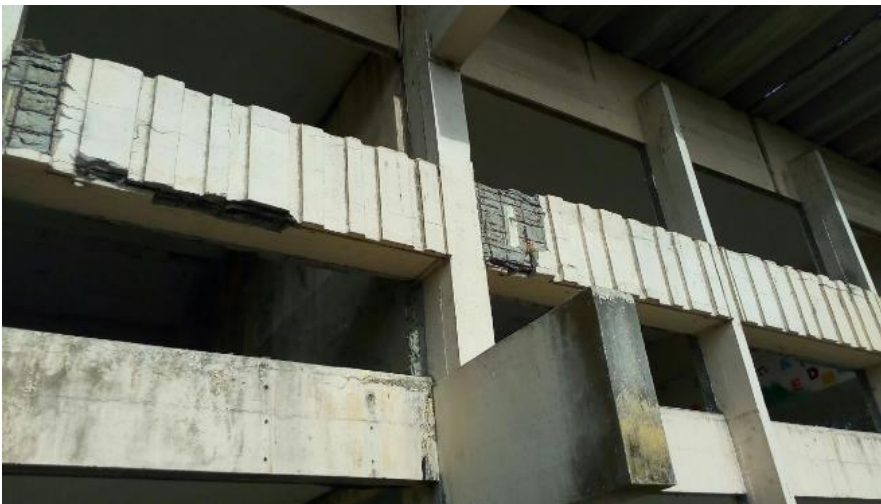
Vigas da Fachada atingida por corrosão da armadura e deslocamentos de concreto. Necessidade de remoção conforme item 7.2.
