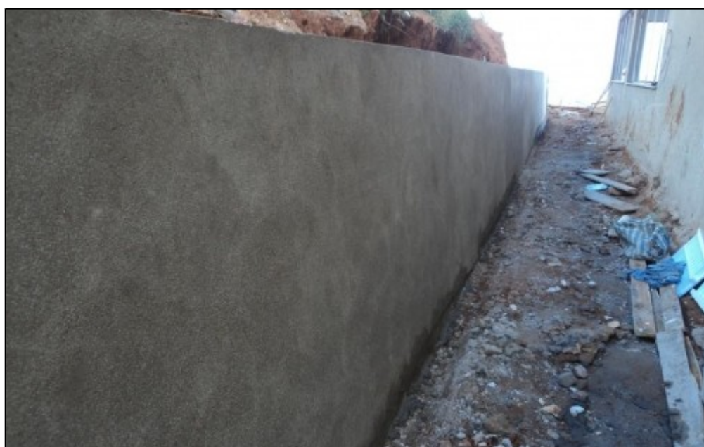
Imagem 32 - Exemplo de Muro Rebocado
