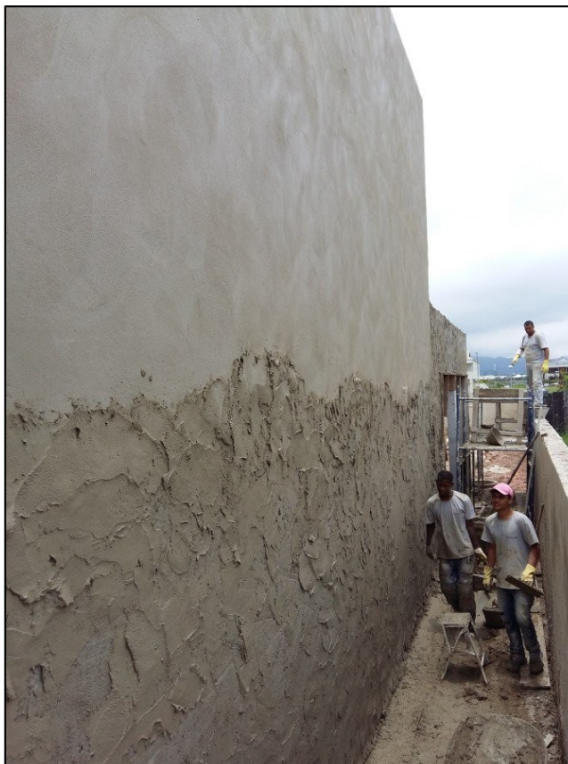
Imagem 33 - Exemplo de Emboço (muro acima)
