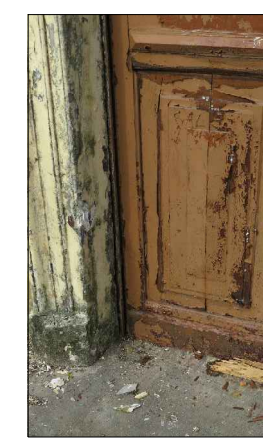
08 GUARNIÇÃO DANIFICADA.
