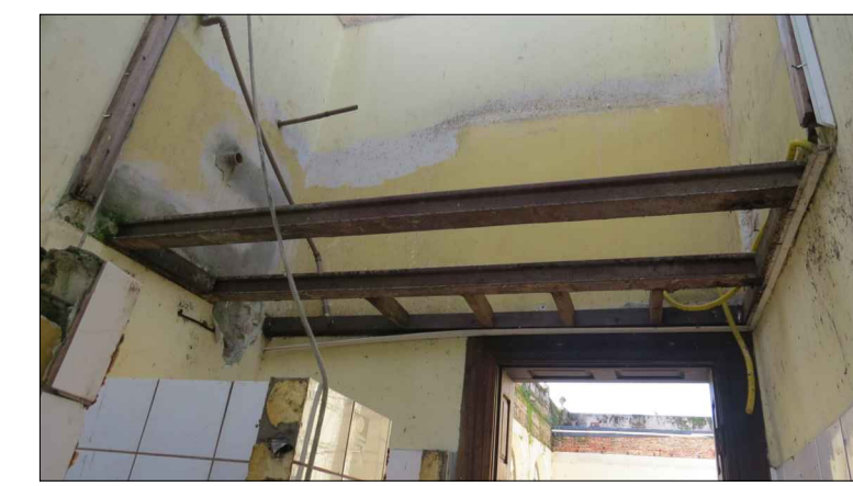
04 APOIO DA CAIXA D'ÁGUA.
