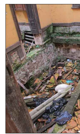
39 ESQUADRIA COM VIDROS E MADEIRA QUEBRADOS.
