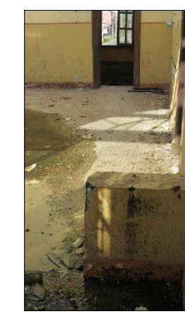
05 PAINÉIS DE MADEIRA RETIRADOS.
