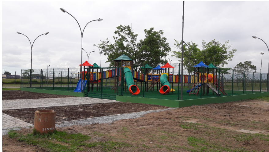
FIGURA 14 - IMAGEM GRADIL COM MURETA
