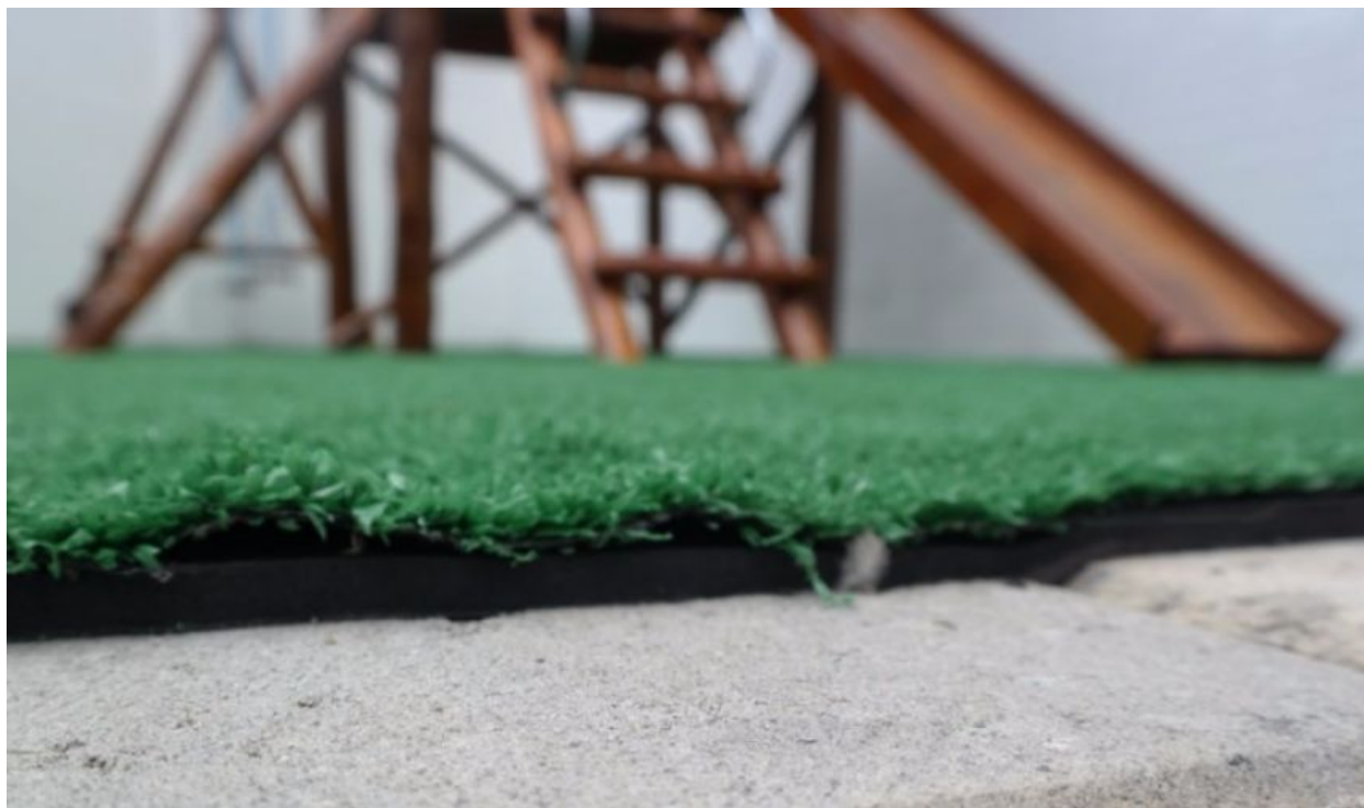
FIGURA 6 - IMAGEM DA BASE PARA INSTALAÇÃO DA GRAMA SINTÉTICA
