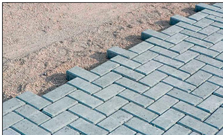
Imagem 14 - Piso Paver - Instalação
