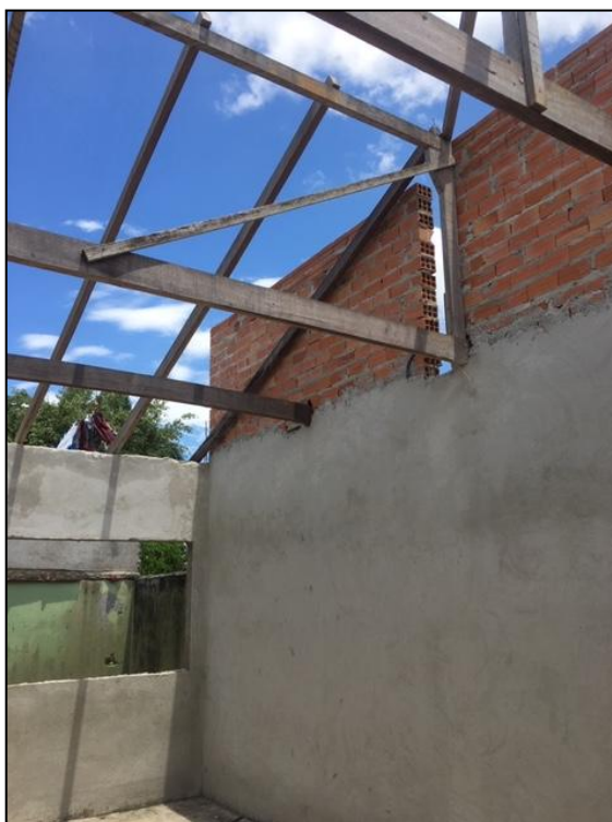
Imagem 06 - Tesoura do telhado a ser completada
