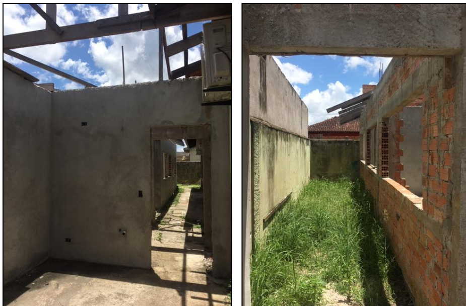
Imagem 03 e 04 - Paredes em Alvenaria já construídas
