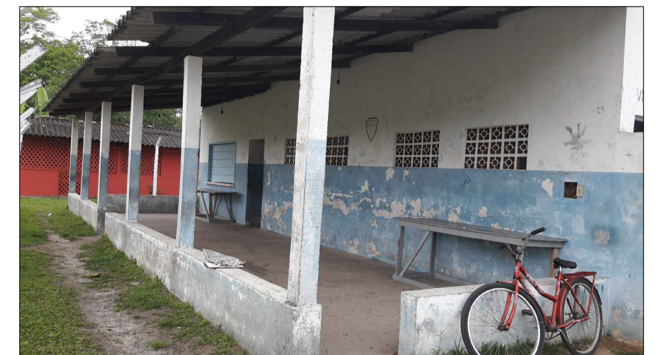
IMAGEM - VESTIÁRIO EXTERNO
