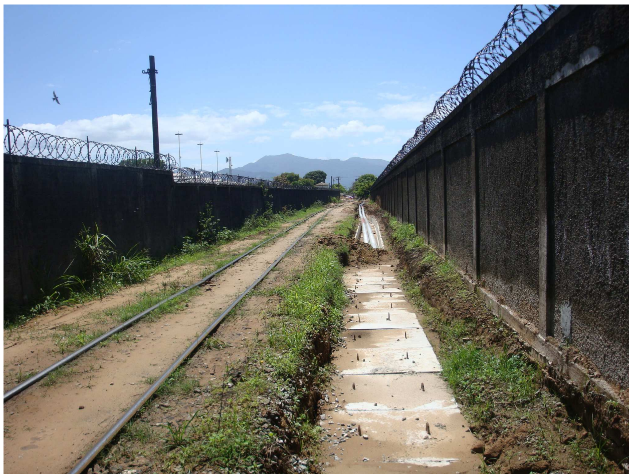
Foto 2.1 – Tubulações com envelope de concreto, ainda em fase de instalação
