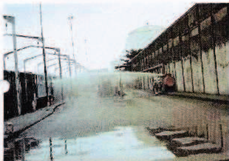
Combate ao incêndio com o canhão 01 acionado com LGE e os outros canhões realizando resfriamentos dos outros vagões
