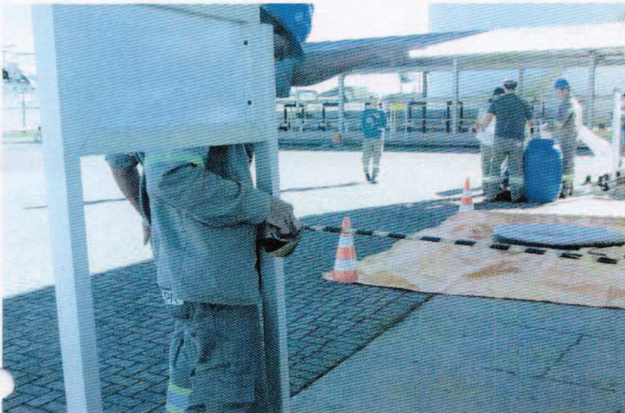
Isolamento da área.
