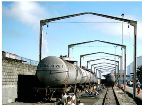
Figura 4 – Desvio ferroviário para descarga de vagões tanque no Terminal de Álcool CPA
