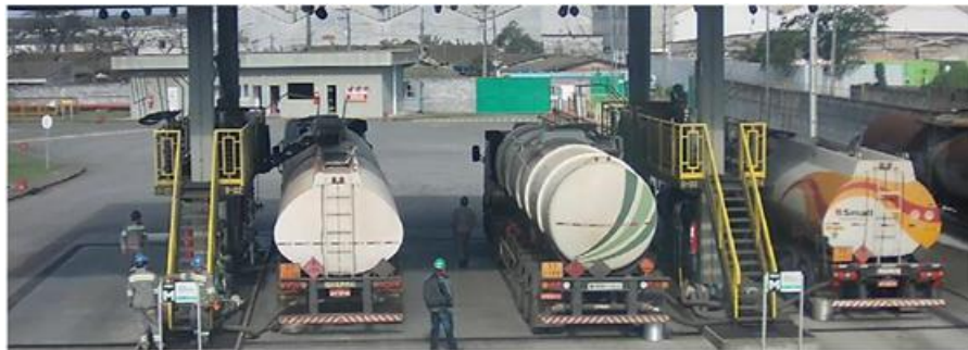
Figura 2 – Baias de descarregamento de caminhões tanque no Terminal de Álcool CPA
