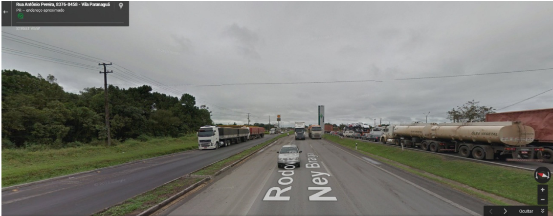
Figura 3-6 - Imagem do acesso a área pela rodovia Governador Ney Braga. Pode-se observar que não existem arborizações planejadas no local.
