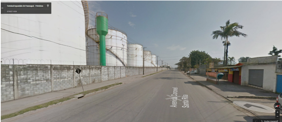
Figura 3-16- Imagem da Av. Cel. Santa Rita em frente ao empreendimento, observa-se que não existem arborizações planejadas no local. Ocorre a incidência de alguns espécimes nas ruas e residências.
