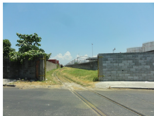
Figura 3-50 - PN e Ramal ferroviário na Rua José Cadilhe
