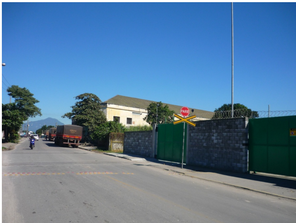
Foto 3-2- Vista da entrada principal atual da área do empreendimento
