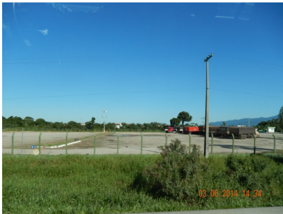
Figura 3-41 - Pátio da PASA (localiza-se no Km 5 da rodovia BR 277)
