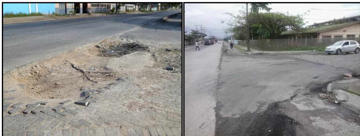
Figura 77 - Comparativo entre melhorias executadas na Av. Getúlio Vargas após firmamento de parceria.
