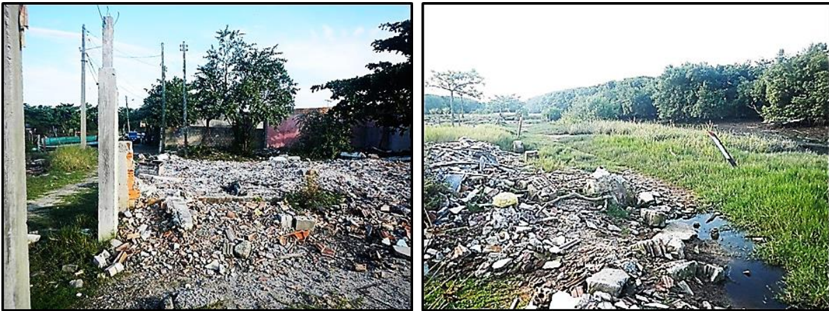
Figura 114 - Casas desapropriadas e demolidas na área do mangue – unidade de paisagem Ocupações de área de mangue.
