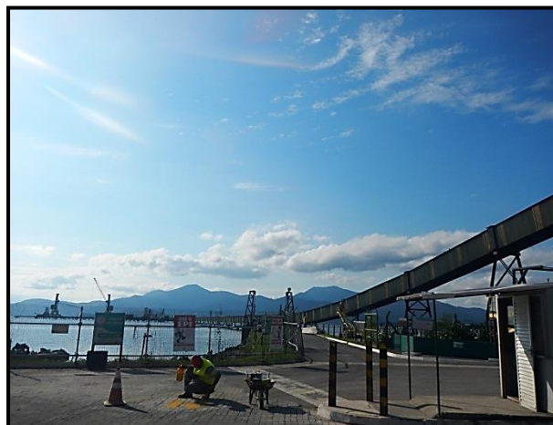
Figura 30 – Correia transportadora entre cais de atracação e torre de recebimento/transferência.
