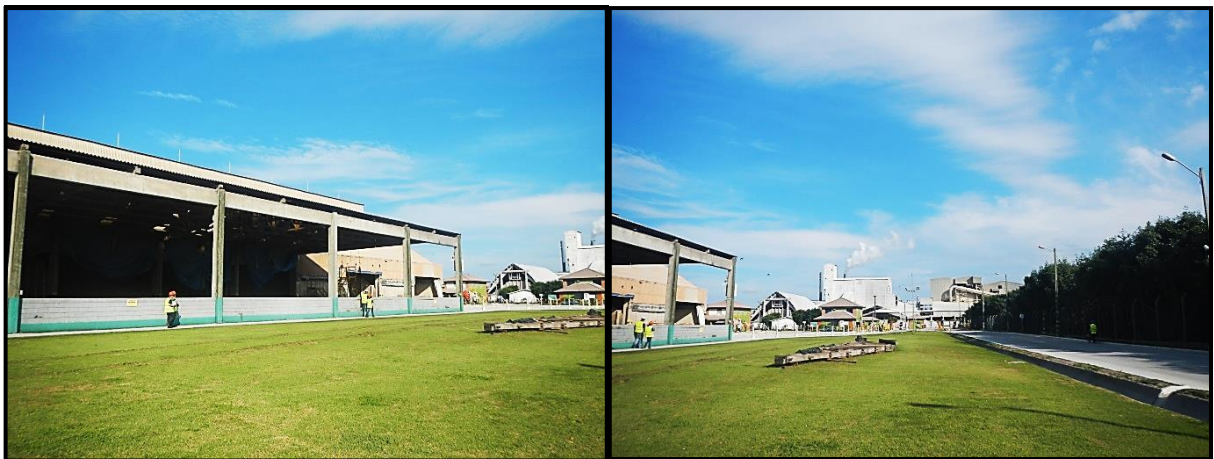
Figura 6 – Vista da área aterrada na ADA do empreendimento.
