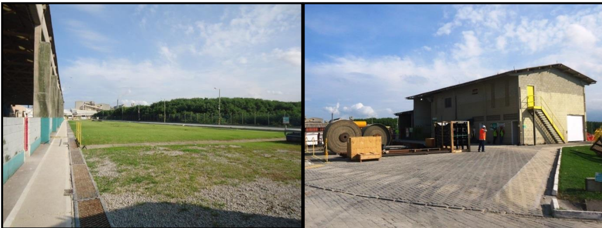
Figura 2 – Vista da área de implantação das estruturas de otimização da unidade.
