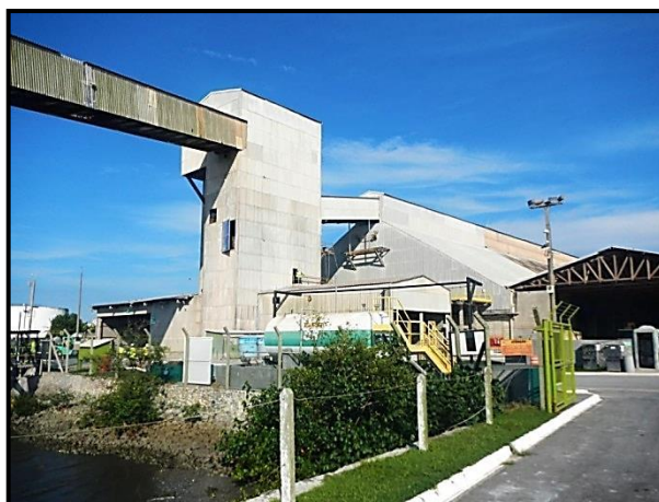
Figura 29 – Torre de recebimento/transferência de fertilizante por meio da correia transportadora
