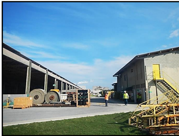
Figura 27 – Local de implantação do novo armazém, sendo necessária a remoção da estrutura à direita.
