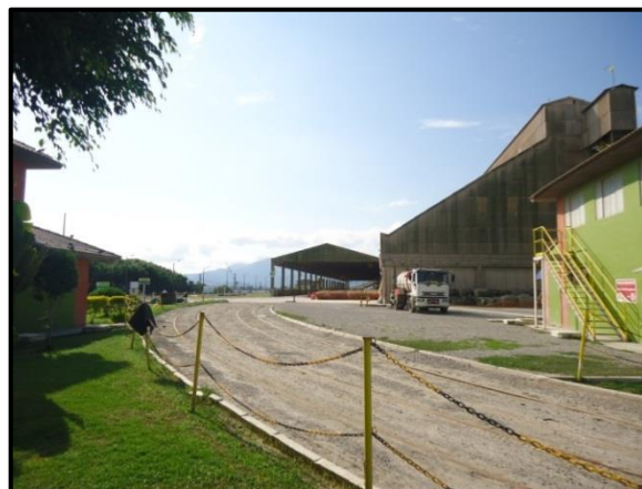
Figura 23 – Linha ferroviária, à esquerda o prédio administrativo, ao fundo o armazém existente e à direita o refeitório/vestiário.
