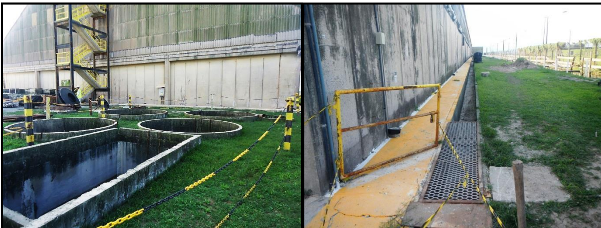
Figura 25 – Tanques de decantação de água pluvial e espaço entre o armazém existente e o muro de separação da FOSPAR S/A. e a Petrobrás. No local será instalada uma via para o fluxo interno de caminhões.
