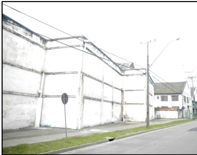
Figura 71 – Infraestrutura de drenagem pluvial.
