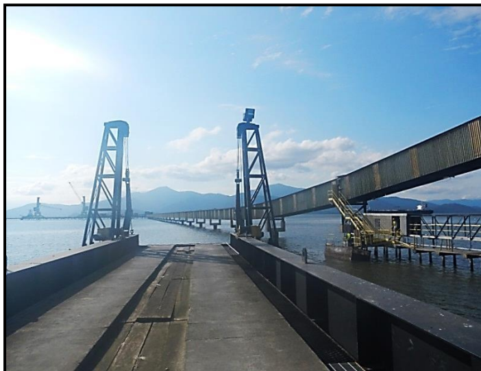
Figura 117 – Vista da plataforma de embarque e da correia transportadora de carga (ao fundo) do Terminal Portuário de Fertilizantes da FOSPAR S/A.
