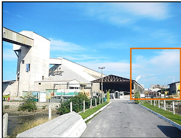
Figura 118 – À esquerda, a torre de carregamento 902-TT-02 existente e, à direita, área de implantação do novo armazém e da tulha 902-TT-03.
