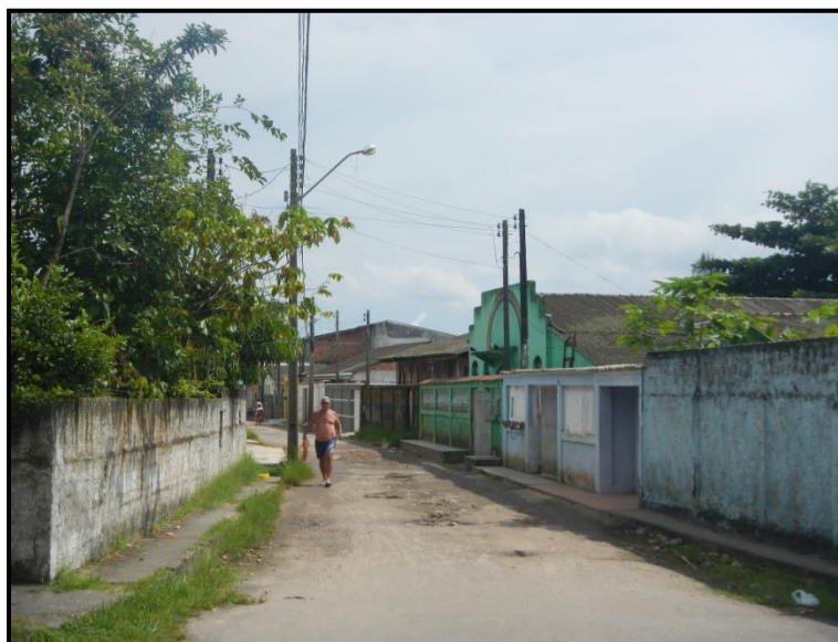
Figura 72 – Áreas sem infraestrutura de drenagem pluvial.
