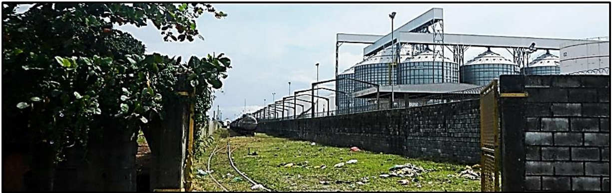
Figura 107 - Trilho ferroviário e silo de grãos - unidade de paisagem Atividades portuárias e correlatas.
