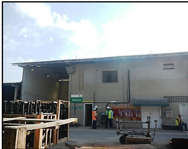
Figura 28 – Em detalhe a mecânica, estrutura que será relocada para implantação do novo armazém.
