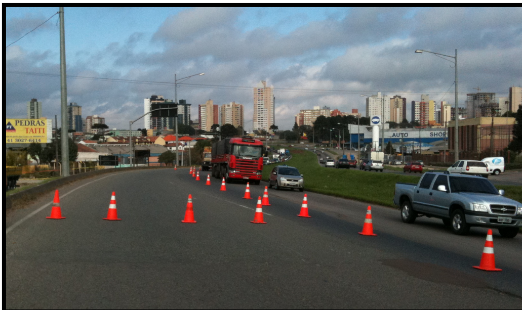
Figura 6-6 - Exemplo de canalização do tráfego com a utilização de cones.
