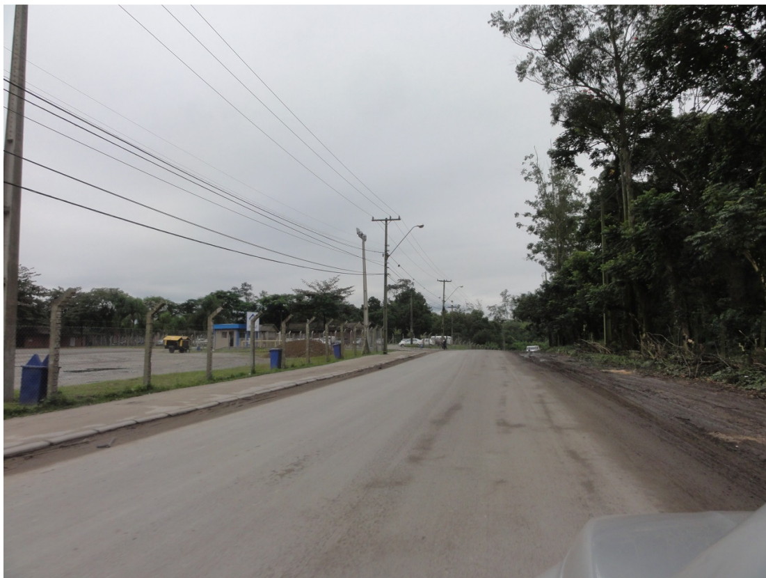
Figura 4-35 - Estrada Velha de Alexandra entre a Estrada do Embocuí e a BRF (Sadia)
