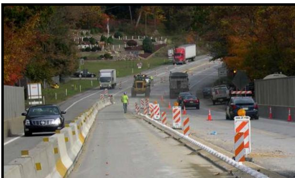
Figura 6-7 - Exemplo de canalização de tráfego com o uso de barreiras plásticas e marcadores de perigo.
