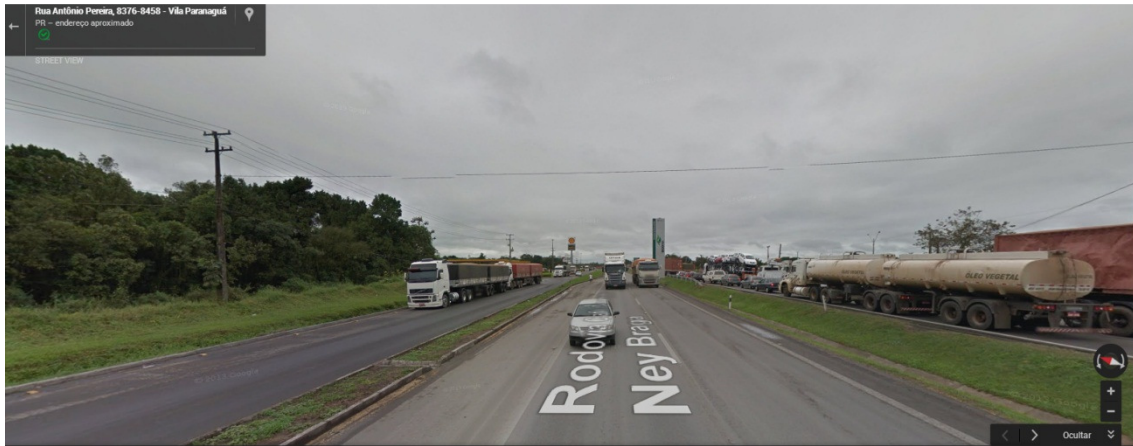
Figura 4-7 - Imagem do acesso a área pela rodovia Governador Ney Braga. Pode-se observar que não existem arborizações planejadas no local.
