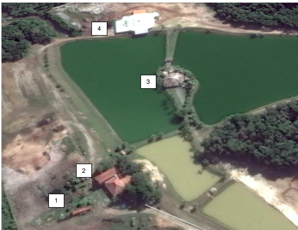
Foto 4-18 – Edificações Parque aquático.
