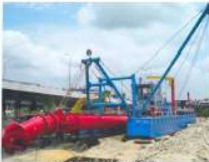
Foto 6: Dragagem em operação
