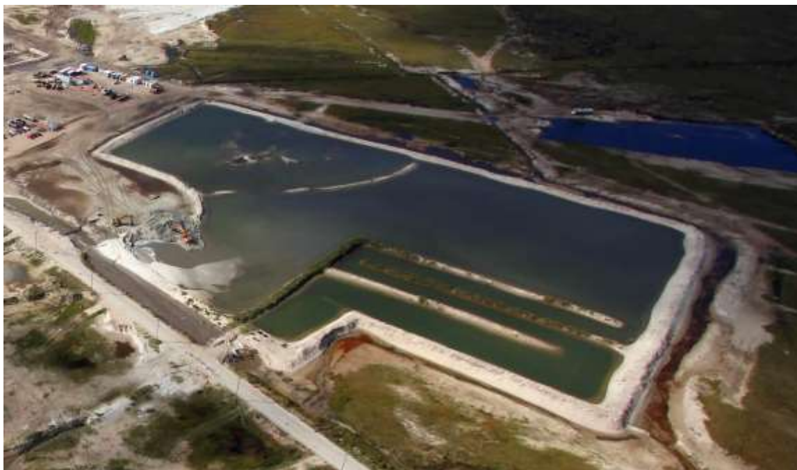
Foto aérea – bacia de sedimentação de dragagem (ilustrativa)
