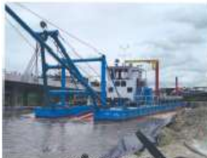
Foto 5: Dragagem em operação
