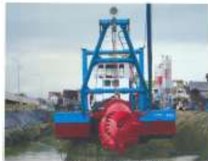
Foto 1: Dragagem em operação
