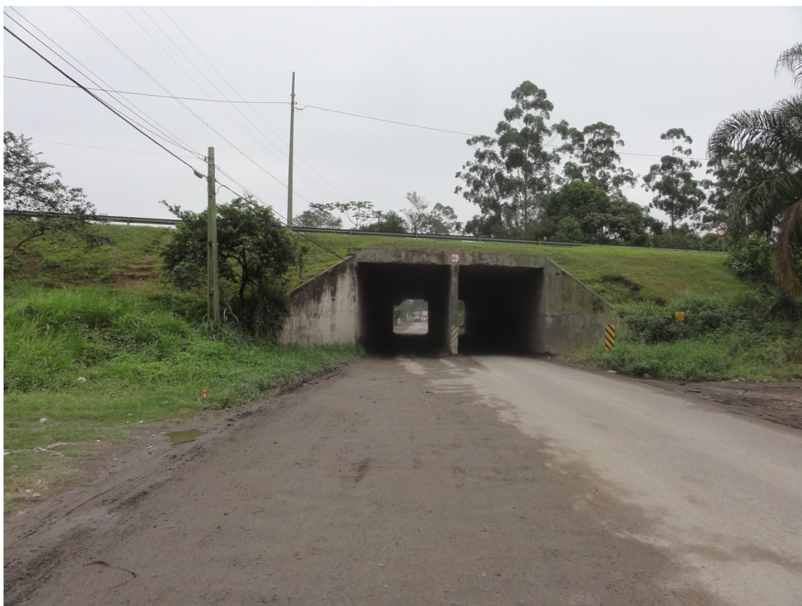
Figura 8-8 - Passagem da Avenida Sen. Atílio Fontana sob a BR-277
