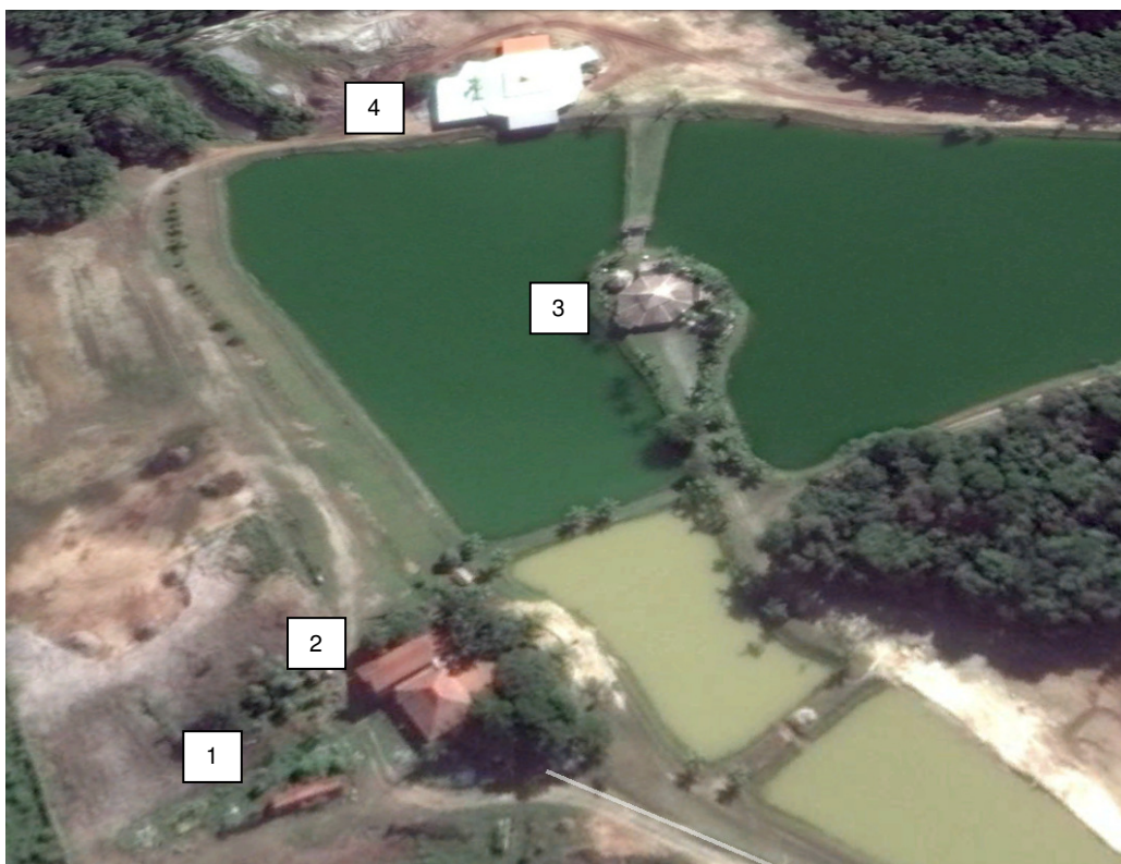
Foto 3-18 – Edificações Parque aquático.
