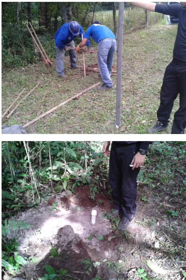
Figura 4-1 - Procedimento de instalação do poço piezômetro: a) Perfuração para instalação de poço piezômetro, utilizando trado helicoidal. Em primeiro plano aparece a coluna de revestimento com o filtro envolvido por manta de bedin, aguardando para ser instalada na perfuração; b) Poço piezômetro já instalado e em operação.
