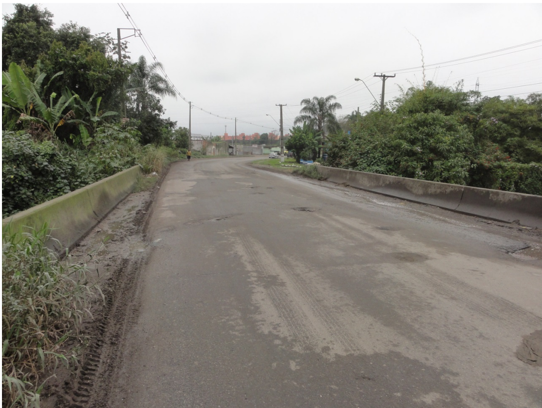
Figura 8-10 - Ponte sobre o Rio Emboguaçu
