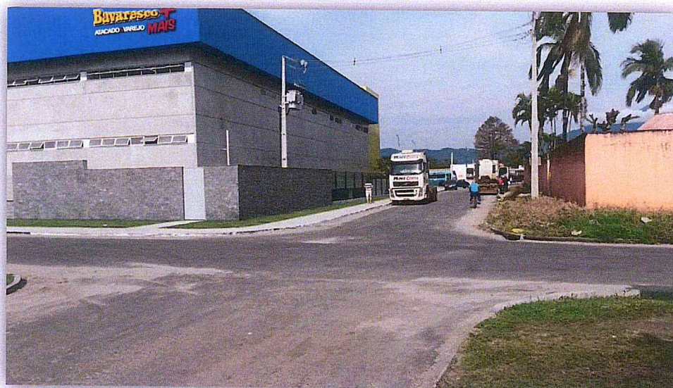
Figura 56. Falta de calçadas
