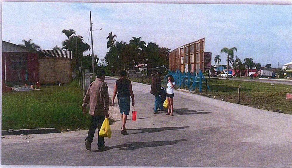
Figura 55. Falta de calçadas
