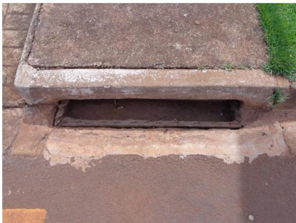
**Figura 80: Bidin na boca de lobo para coletar material particulado.**
