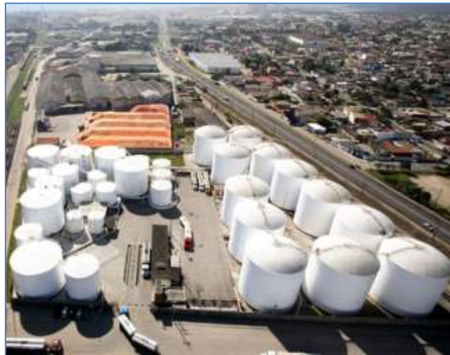
Foto 2-2 – Tanques do Terminal 2.
