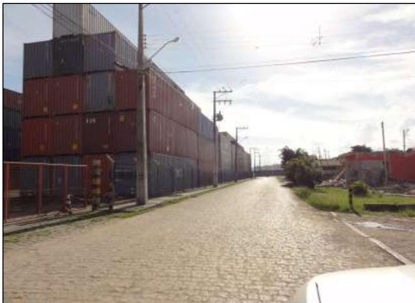
Foto 4-20 - Rua Dona Ludovica Bório sentido S > N.
