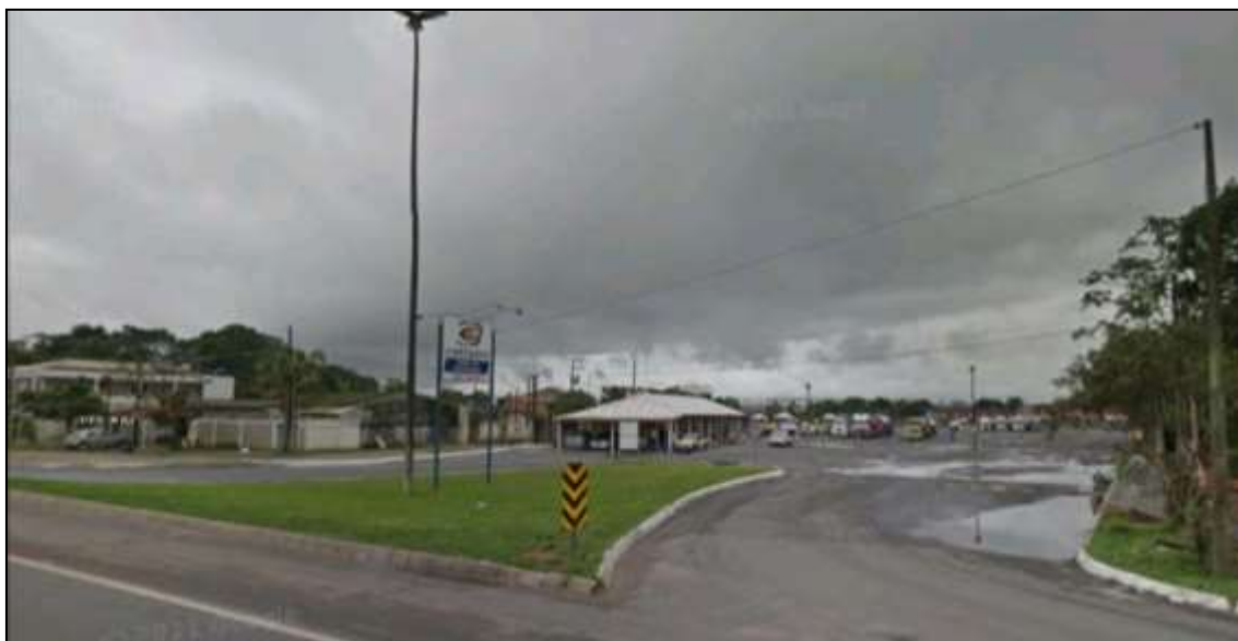
Foto 4-17- Entrada do pátio de estacionamento.
