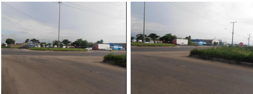
Foto 8 - Rótula de acesso a BR 277 (Av. Ayrton Senna) Fonte: Elaborado por Schneider engenharia
