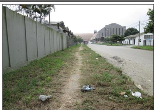
Futuro acesso pela Rua Francisco Machado. Calçada em péssimas condições de conservação.
