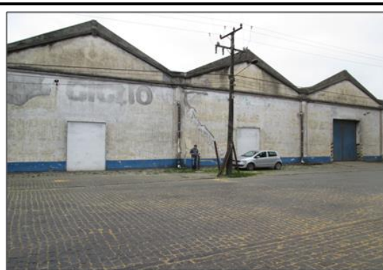
Fachada atual do empreendimento.
