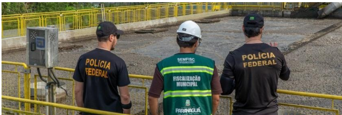
Atuação conjunta em estrutura vinculada à Estação de Tratamento de Esgoto Sanitário.
