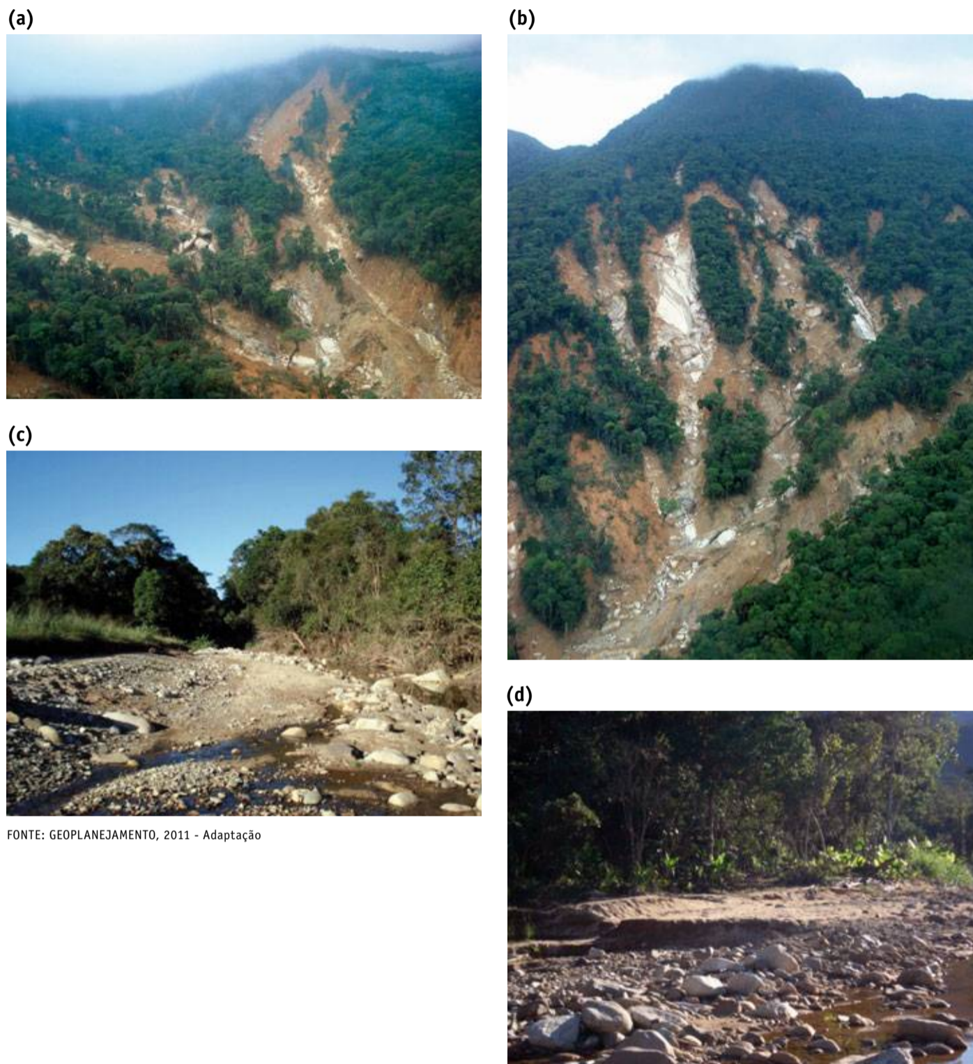
FIGURA 3.1.10 - ASPECTOS DOS LOCAIS AFETADOS POR DESLIZAMENTOS E FLUXOS DE DETRITOS NA SERRA DA PRATA (A E B). EM (C E D), ACÚMULO DE SEDIMENTOS, SEIXOS E PEQUENOS BLOCOS NAS ÁREAS DE ASSOREAMENTO NA PLANÍCIE
