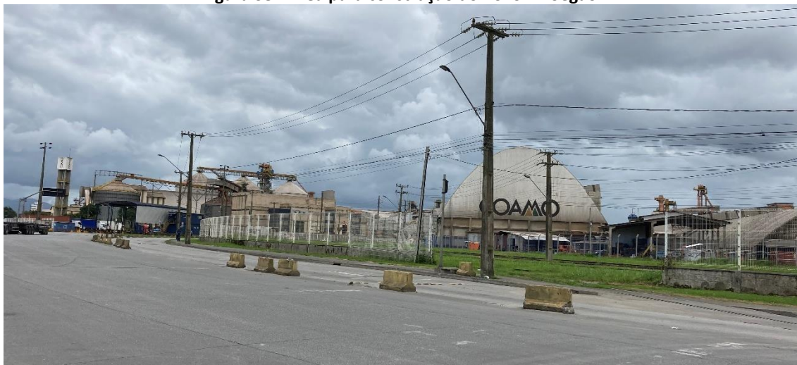
Figura 38 - Área para construção do novo "moegão"
