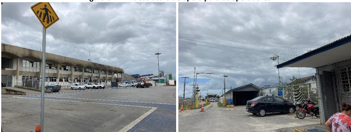
Figura 37 - Infraestrutura de apoio para os operadores
