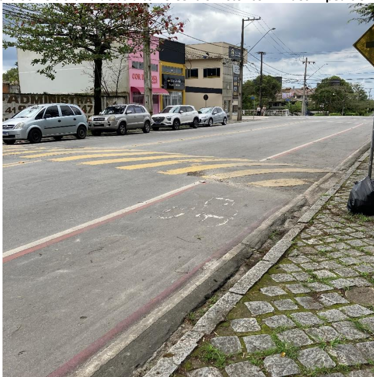
Figura 30 - Ciclofaixa de asfalto no Centro Histórico – R. dos Expedicionários
