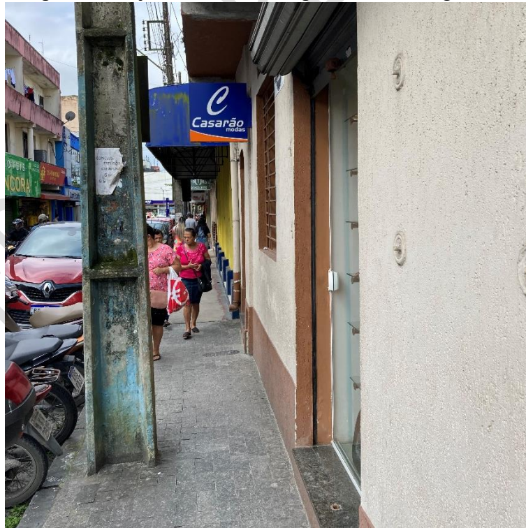
Figura 19 - Calçada de 0,81 m de largura na R. Des. Hugo Simas
