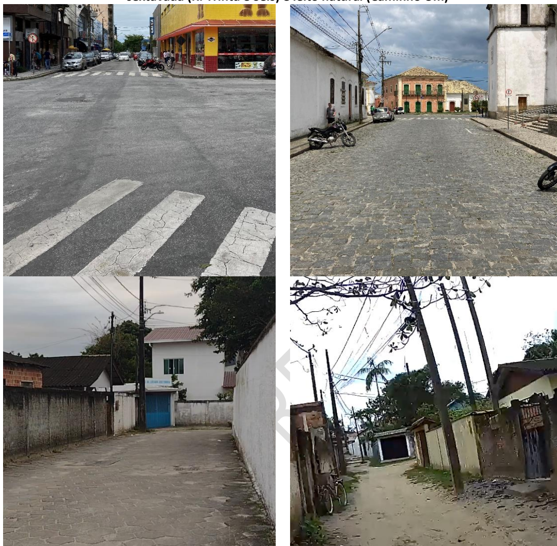
Figura 14 - Revestimentos: asfalto (R. Doutor Leocádio), paralelepípedo (R. Professor Cleto), lajota sextavada (R. Trinta e Seis) e leito natural (Caminho Um)
