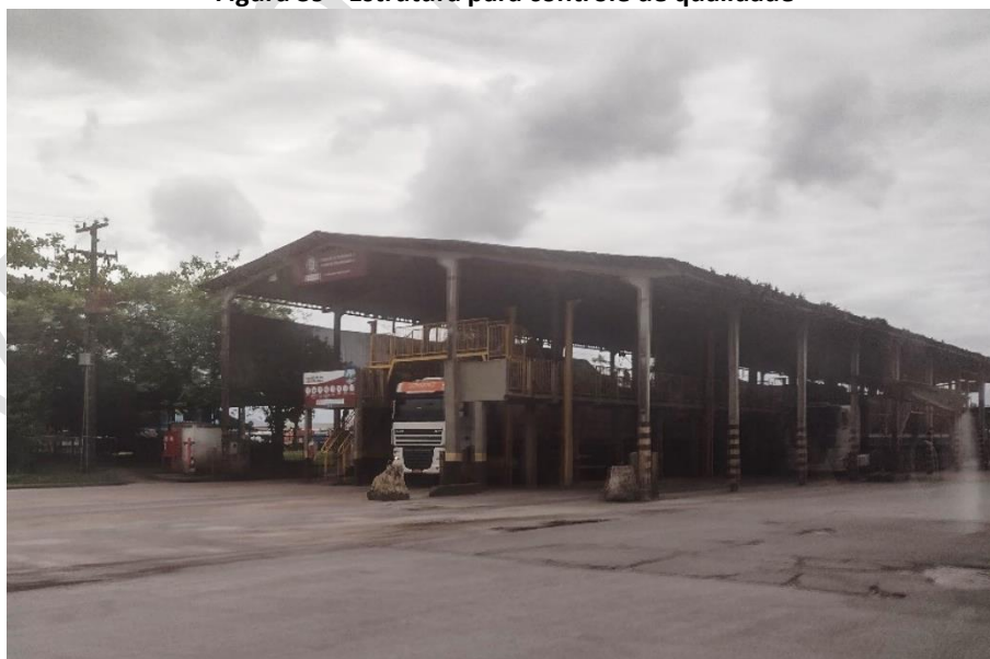
Figura 39 - Estrutura para controle de qualidade
