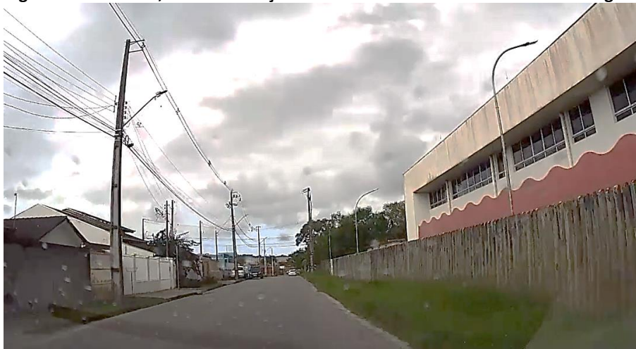
Figura 20 - À direita, local com calçada inexistente – Av. Antônio Carlos Rodrigues
