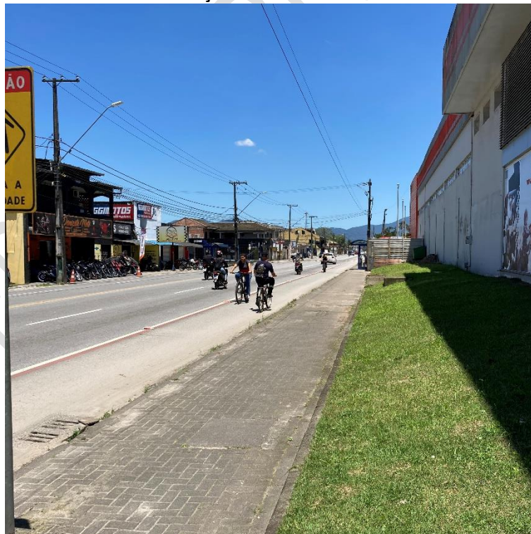
Figura 31 - Ciclofaixa em boas condições – Av. Governador Bento Munhoz da Rocha Neto
