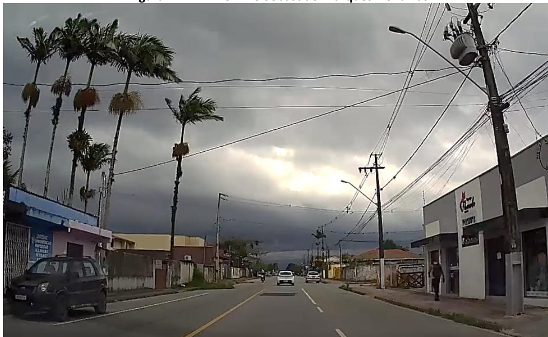
Figura 12 – Av. Belmiro Sebastião Marques – 3 faixas
