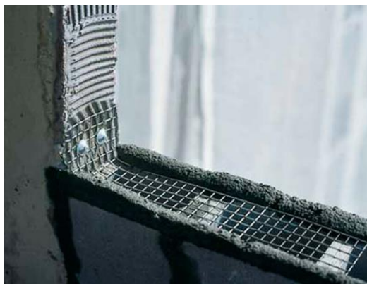
Fixação de alvenaria com tela eletrosoldada
