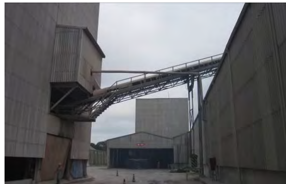
Esteira coberta para envio do SSG para o armazenamento
