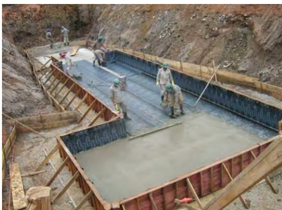
Impermeabilização com manta, antes da concretagem na área da moega de descarga de enxofre (fev/2008).
