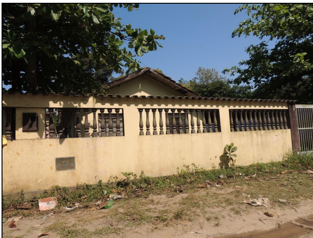
Foto 5.5 - Residência em alvenaria na área do entorno.
