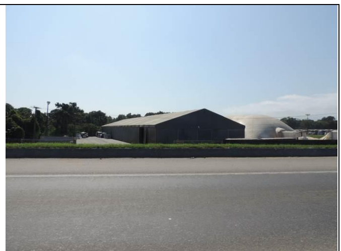
Foto 5.12 - Vista parcial do Terminal de Cargas em frente ao pátio de triagem.
