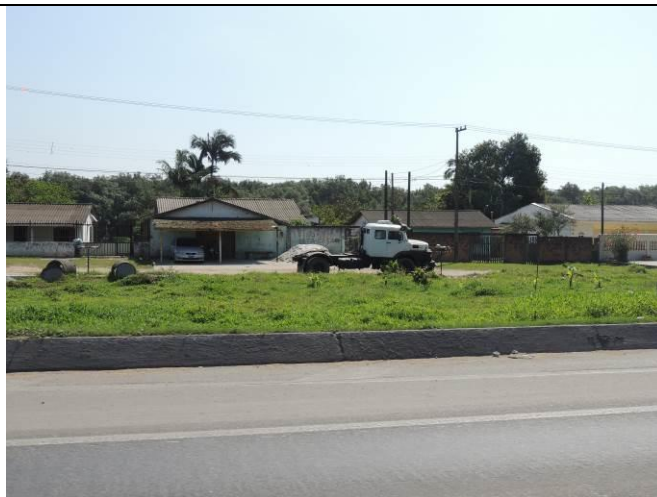
Foto 5.22 - Residências próximas à BR-277.
