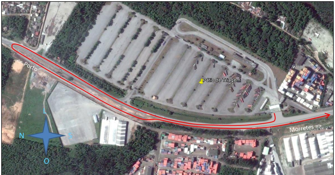
Figura 5.34 - Retorno irregular nas proximidades do empreendimento.
