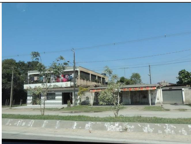
Foto 5.19 - Construção de uso misto na AID do empreendimento.
