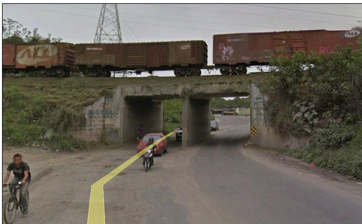
Figura 5.23 - Passagem inferior – Fonte: Google Street View.
