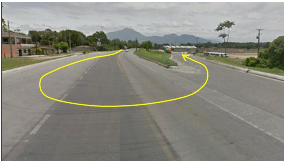
Figura 5.35 - Retorno irregular nas proximidades do empreendimento.
