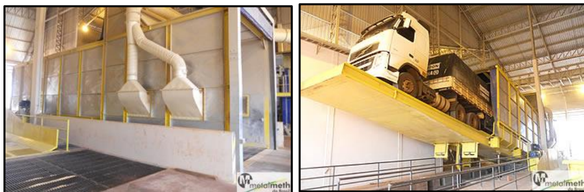
Figura 8 – Sistema de despoeiramento que será implantado na moega.
