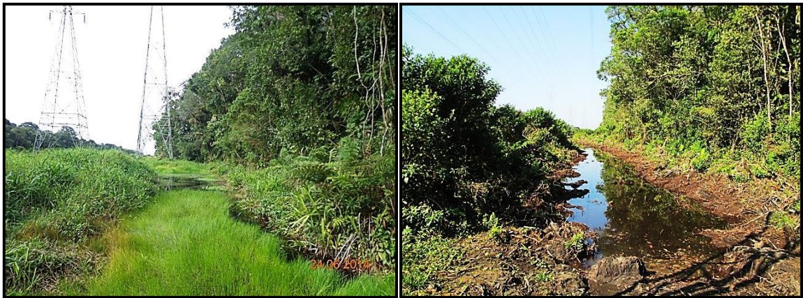
Figura 6 – Vistas das LTs e faixa de servidão, com acúmulo de água, fundos do terreno.
