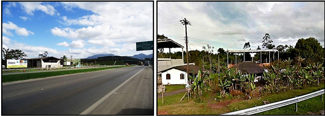
Figura 8 – Vista das residências, comércio e barracões próximos a partir do terreno (esq.) e no detalhe (dir.).
