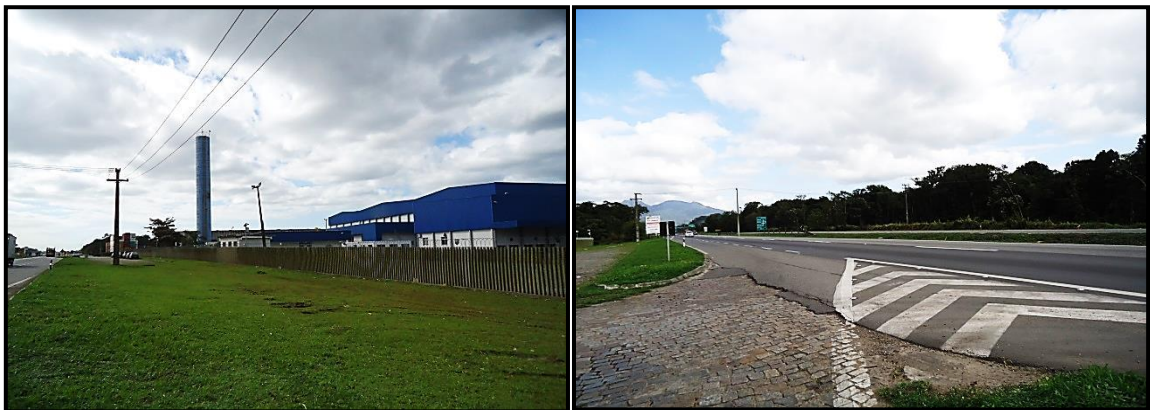
Figura 7 – Vista da fachada da Martini Meat Armazéns Gerais S /A (esq.) e da ADA, na margem oposta, a partir da Martini Meat (dir.).
