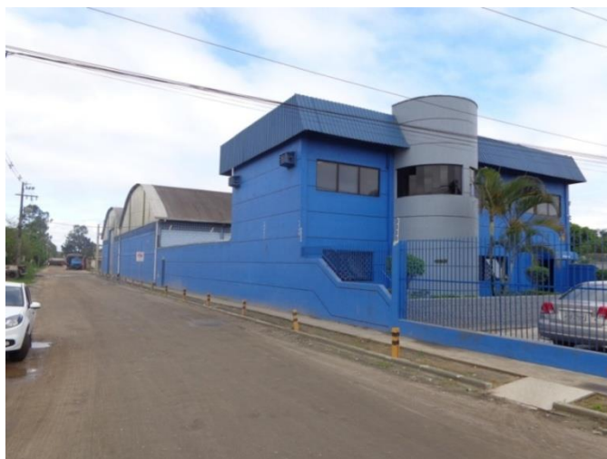
Figura 12: Edificação na Rua Beco 01. Fonte: Master Ambiental, 2014.
