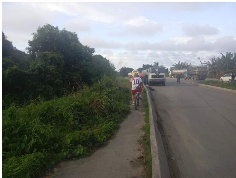
Figura 28: Falta de manutenção da vegetação rasteira na ciclovia próxima ao empreendimento. Fonte: Master Ambiental, 2016.
