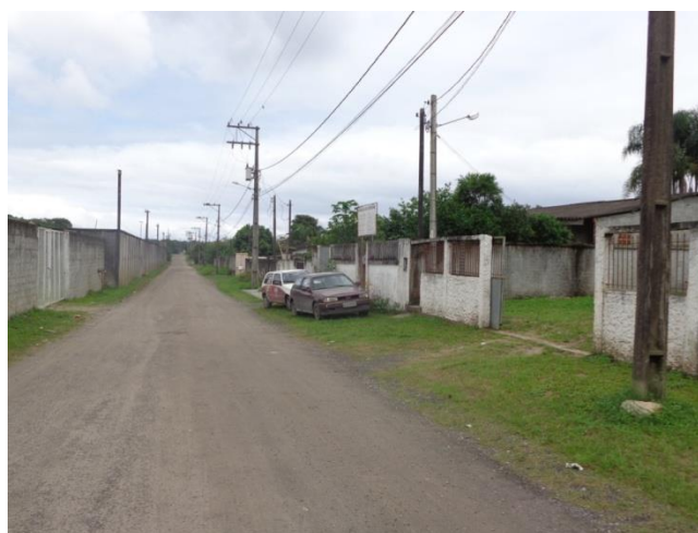
Figura 17: Rua 10, Bairro em processo de regularização. Fonte: Master Ambiental, 2014.
