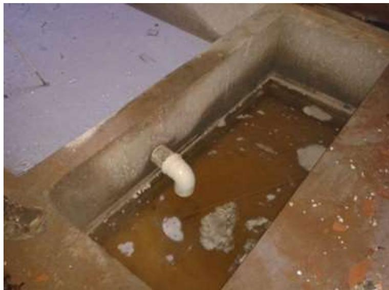
**Figura 89: Sistema de decantação de água de betoneira.**
