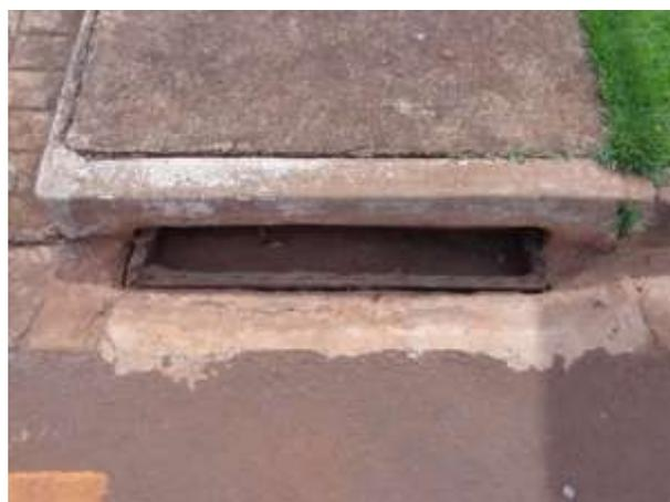
**Figura 93: Bidin na boca de lobo para coletar material particulado.**
