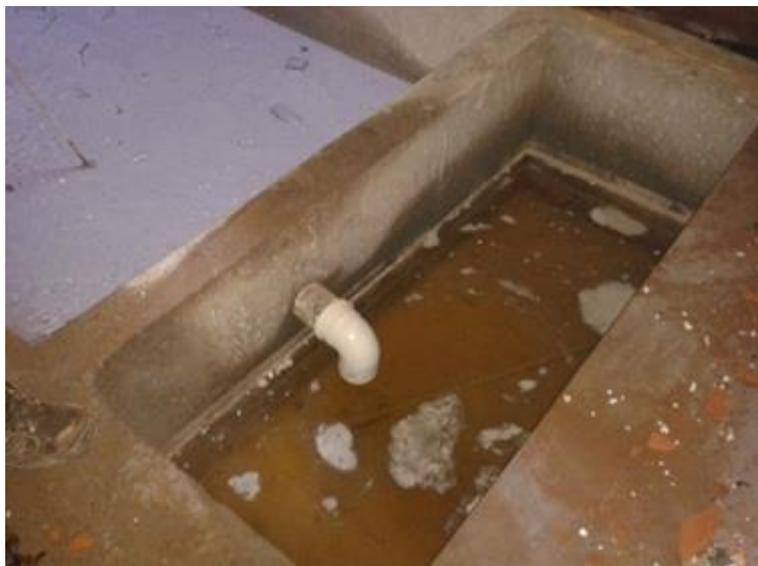
**Figura 15: Sistema de decantação de água de betoneira.**
