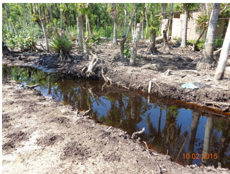
Figura 55: Drenagem a 300 metros a norte do empreendimento Fonte: Master Ambiental
