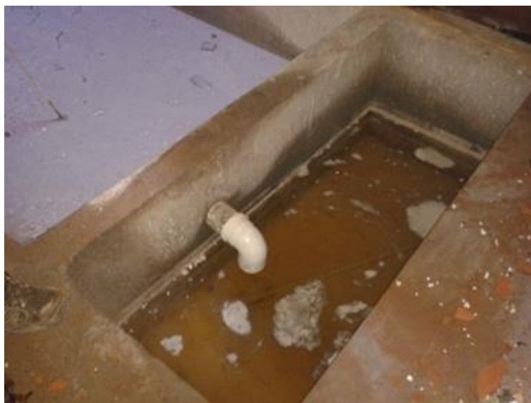
Figura 96: Sistema de decantação de água de betoneira. Fonte: Master Ambiental.
