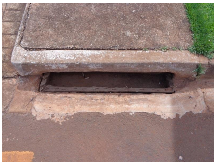
Figura 100: Bidin na boca de lobo para coletar material particulado. Fonte: Master Ambiental
