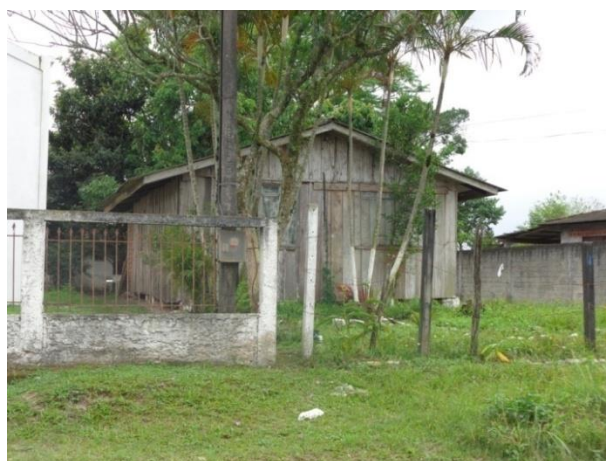
Figura 44: Rua 10, Bairro em processo de regularização. Fonte: Master Ambiental, 2014.
