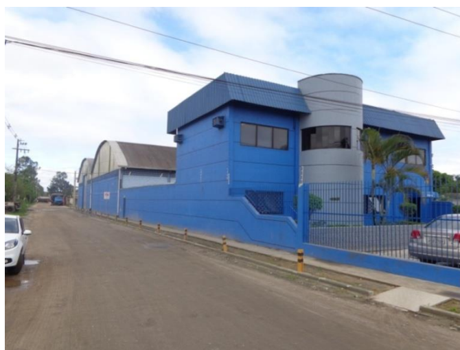
Figura 37: Edificação na Rua Beco 01. Fonte: Master Ambiental, 2014.
