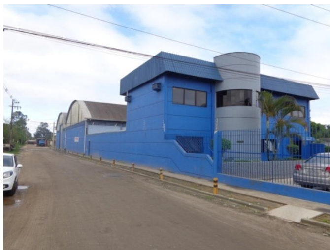
Figura 27: Edificação na Rua Beco 01. Fonte: Master Ambiental, 2014.
