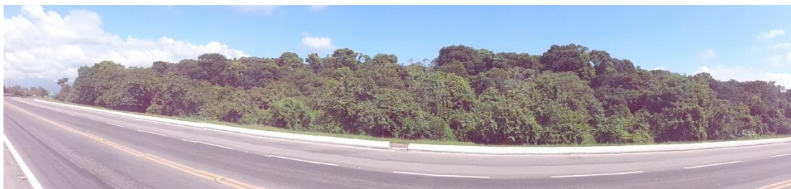
Figura 80: Fotografia panorâmica da frente do empreendimento.
