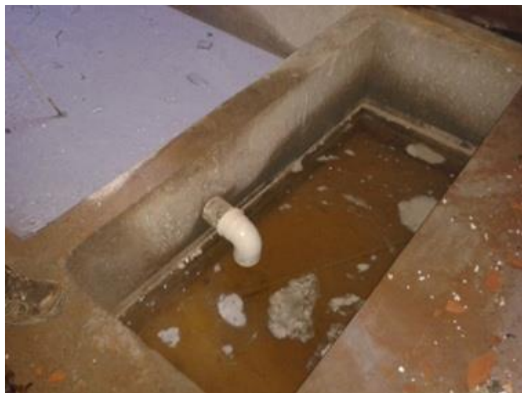
Figura 81: Sistema de decantação de água de betoneira. Fonte: Master Ambiental.
