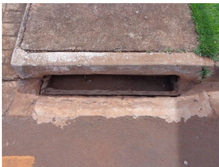
Figura 85: Bidin na boca de lobo para coletar material particulado. Fonte: Master Ambiental
