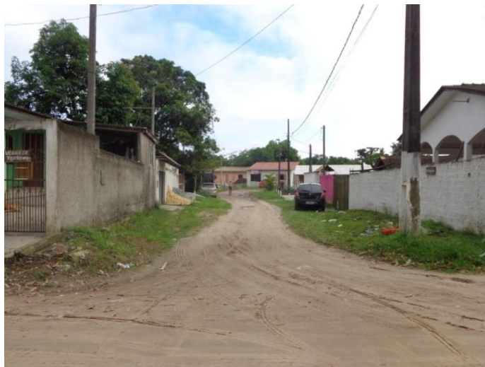
Figura 26: Rua Beco 01-edificações de ocupação irregular. Fonte: Master Ambiental, 2014.
