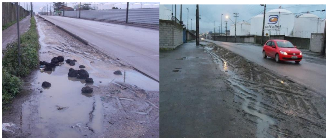
Figura 65: Acúmulo de grãos que caem nas laterais das Avenidas. Fonte: Miranda (2014).
