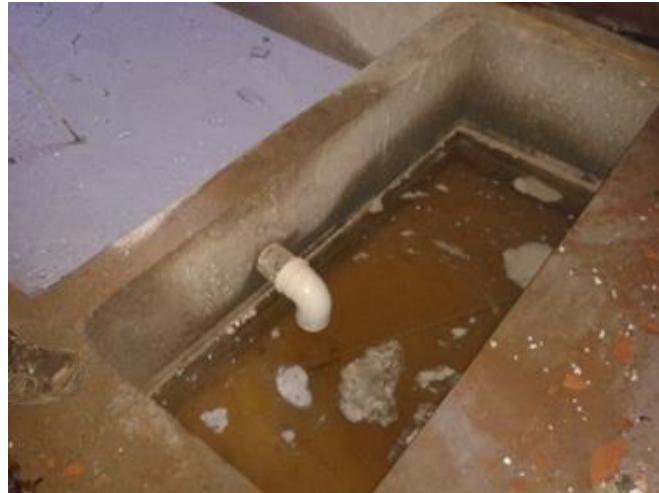
Figura 8: Sistema de decantação de água de betoneira. Fonte: Master Ambiental.
