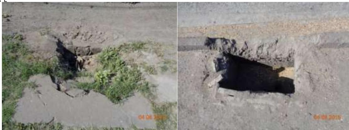
**Figura 57: escoadouro para drenagem pluvial urbana com acentuado grau de degradação.**
