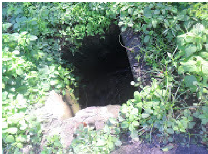
Foto 3-19 - Boca de lobo na Avenida Bento Rocha próximo a PASA (05/06/2014).
