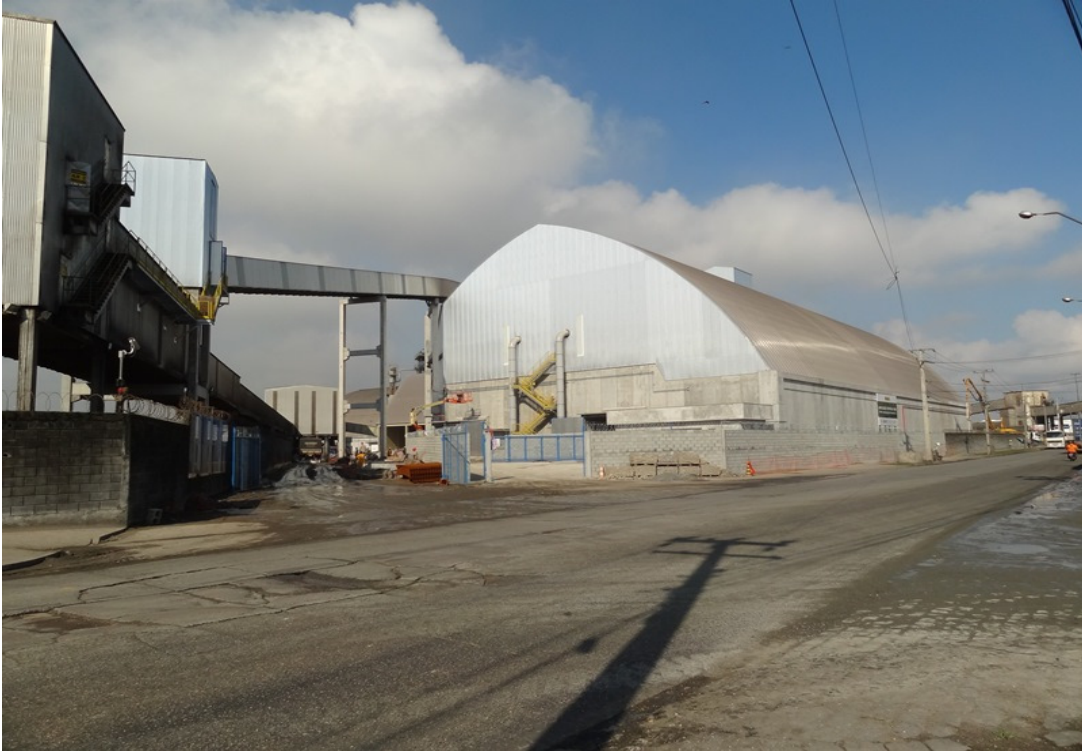
Foto 3-13 - Vista da lateral Norte do terreno pela Rua Bento Rocha. Fonte: Grupo Index, 13 de Junho de 2014.
