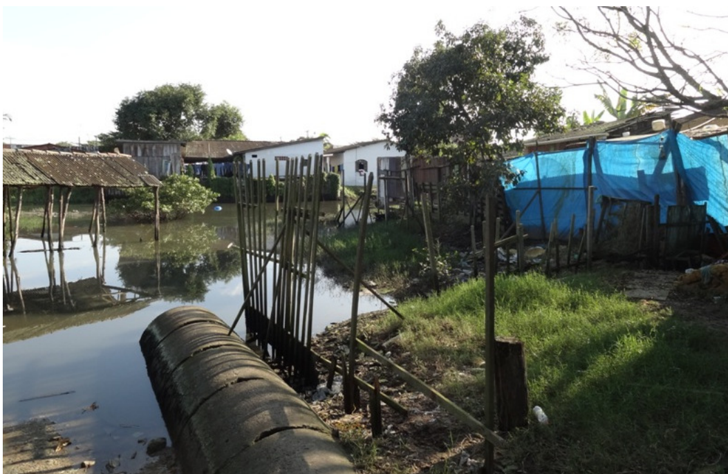
Foto 3-1 - Casas próximas às margens do Canal Anhaia.
