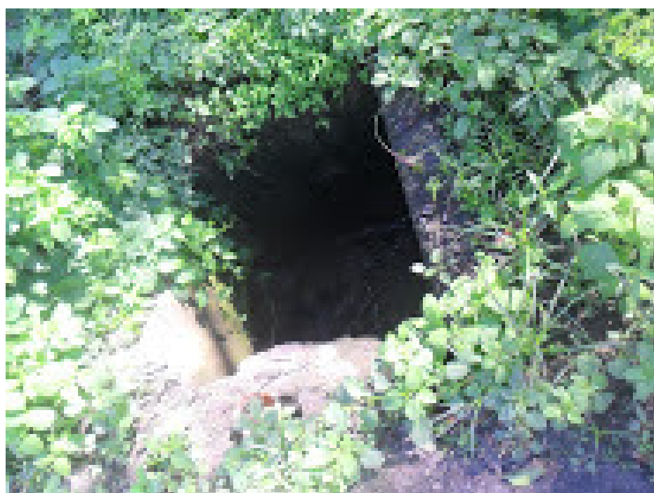
Foto 2-2 - Boca de lobo na Avenida Bento Rocha próximo a PASA (05/06/2014).
