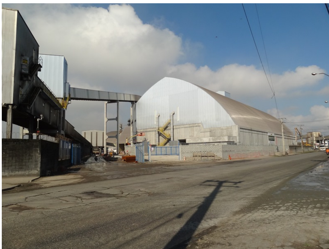
Figura 3-95 - Imagem (Y) após a instalação, contendo o armazém.
