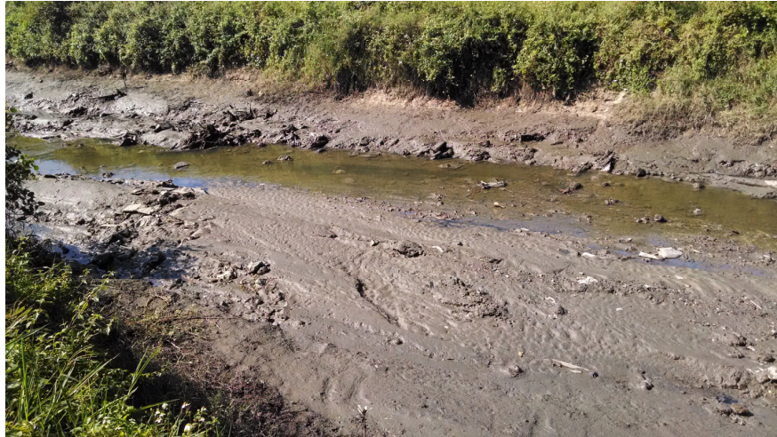
Figura 3-50. Ponto P07: Detalhe no processo de assoreamento do córrego – Coordenadas X, Y 748296, 7176838
