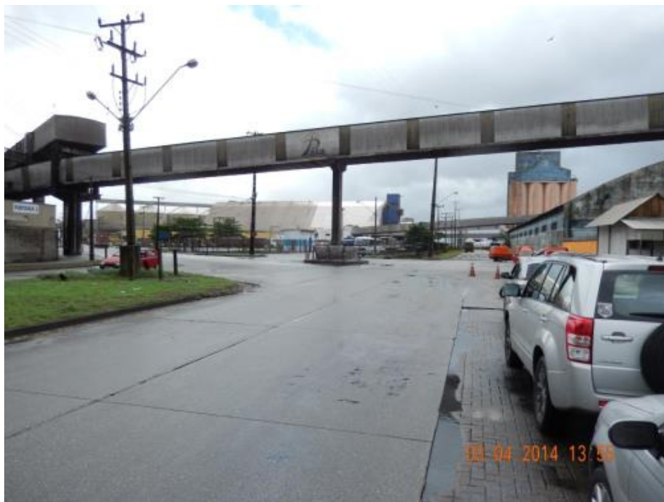
Figura 3-64 - Esquina Avenida Portuária com Avenida Bento Rocha.
