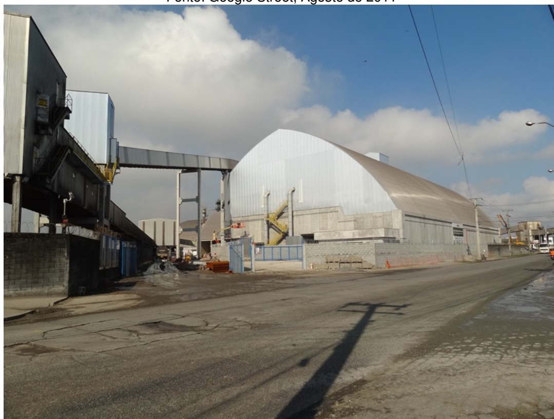
Foto 5-2 - Vista da lateral Norte do terreno pela Rua Bento Rocha.
