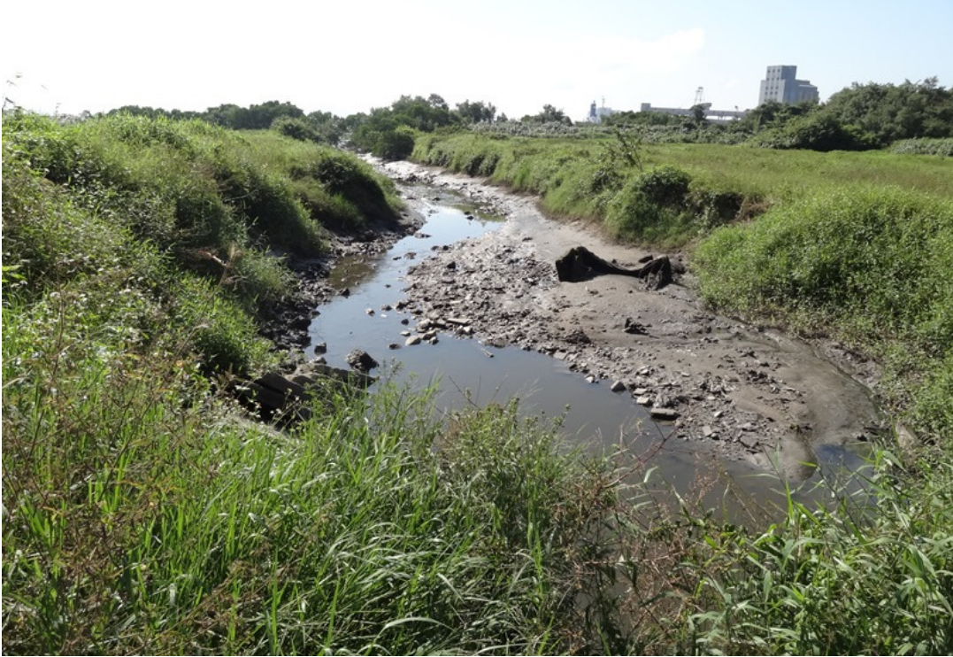
Foto 3-7 – Curso d'água (drenagem de águas pluviais) no ponto 007.
