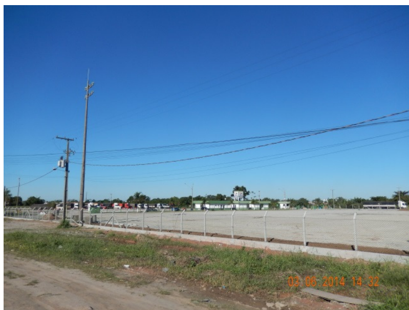
Figura 3-70 - Pátio da PASA ampliação
