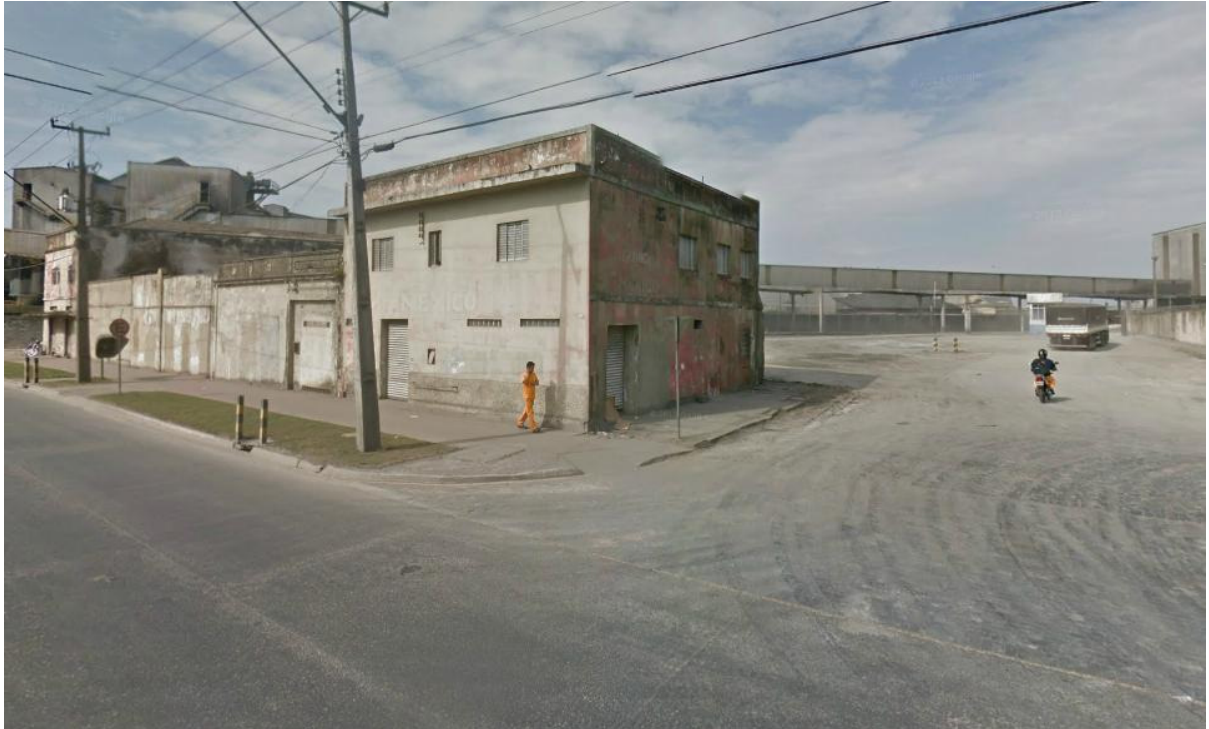
Figura 3-4 - Vista frontal do terreno pela Rua Bento Rocha antes da implantação.
