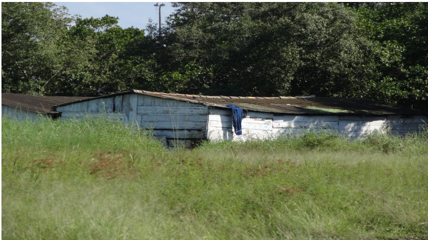
Figura 3-45. Ponto P05: Detalhe de moradia irregular em áreas de restinga – Coordenadas X, Y 748224, 7176978
