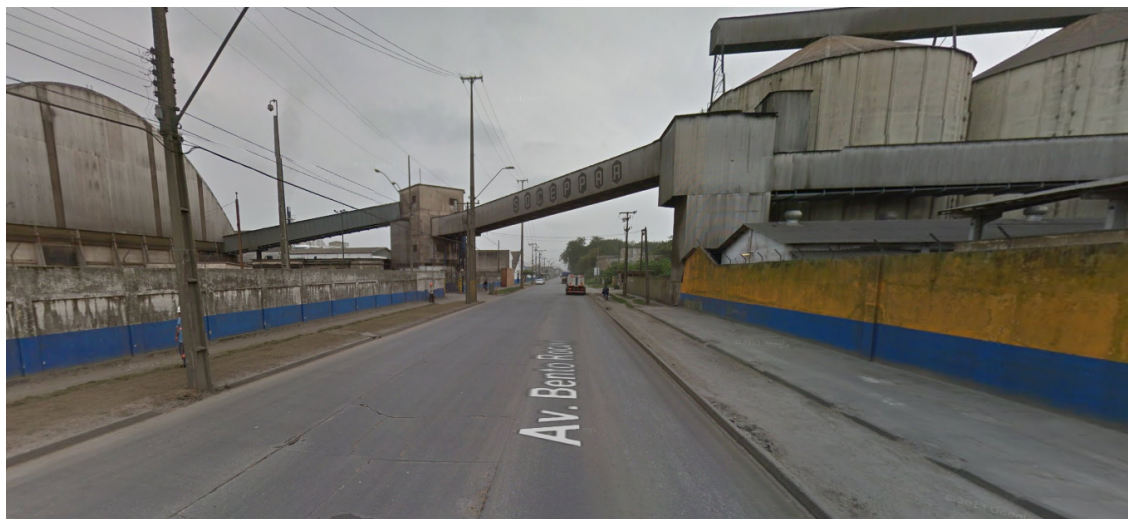
Figura 3-99 - Imagem próxima a ADA da PASA, Silos e Galpões utilizados para atividades portuárias.
