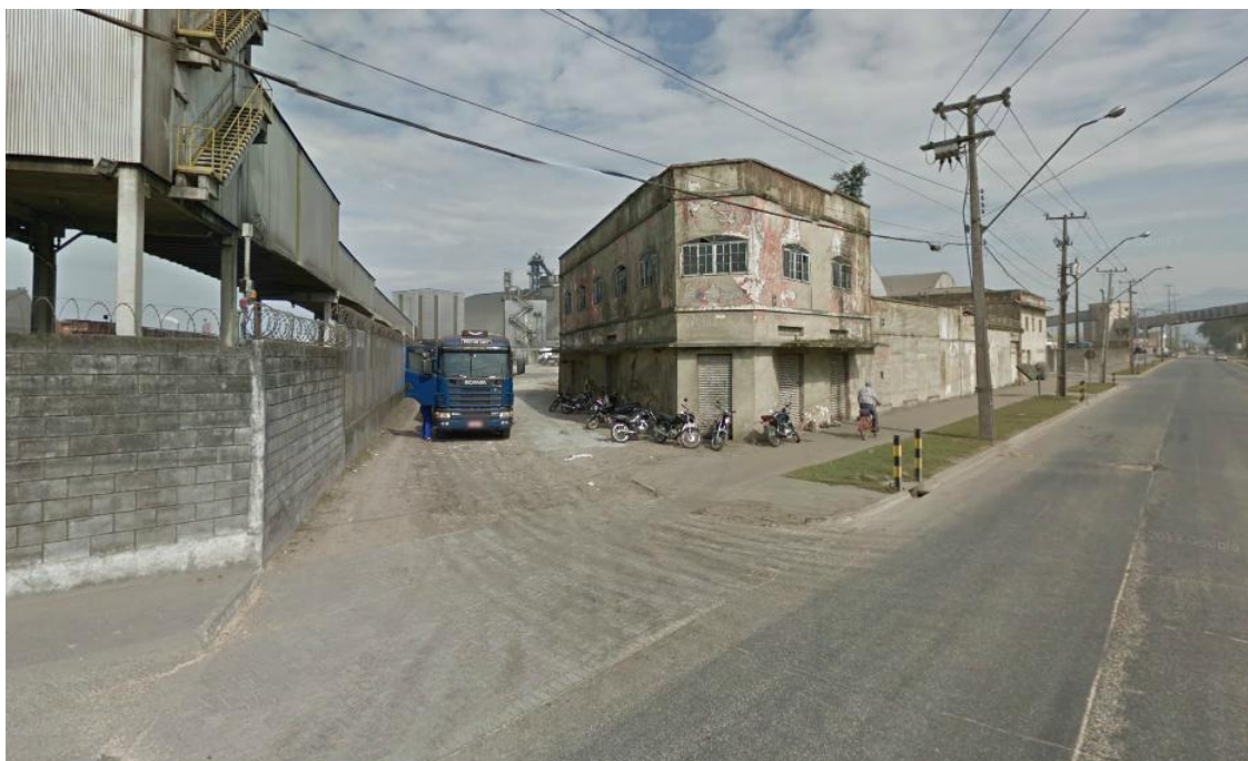
Foto 5-1 - Vista da lateral Norte do terreno pela Rua Bento Rocha.
