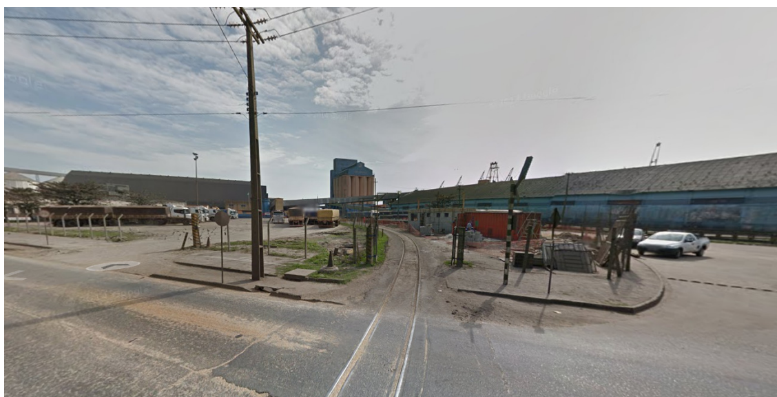
Figura 3-98 - Imagem próxima à ADA da PASA: Galpões utilizados para atividades portuárias.
