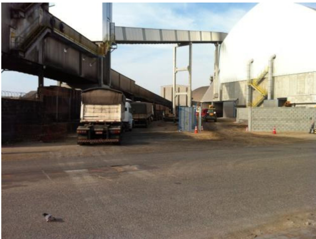
Figura 3-68 – Segundo portão de entrada na Avenida Bento Rocha, que deixará de ser usado após a obra de abertura do novo portão.
