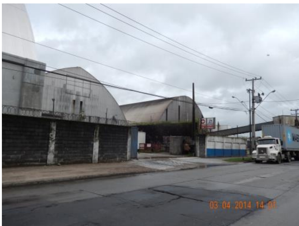
Figura 3-66 – Portão de entrada na Avenida Bento Rocha que será reformado.
