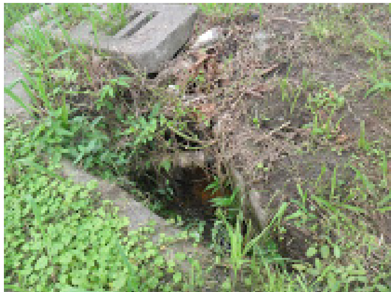
Foto 3-18 - Sistema de manilha no Jardim Guadalupe (05/06/2014).
