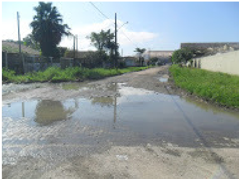
Foto 3-20 - Alagamento e lixo acumulado nas esquinas da Rua Professor Cleto com a Rua José Thomas (05/06/2014).
