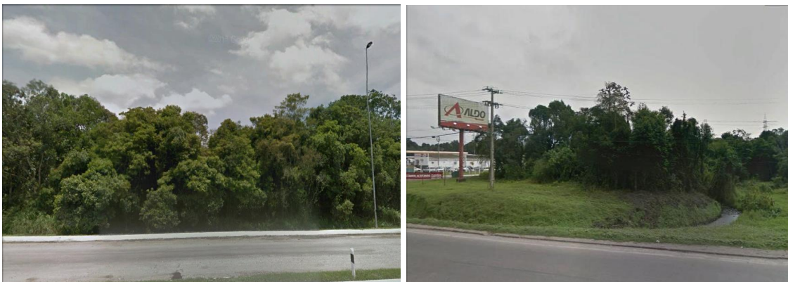
Foto 4 - Vegetação viária da BR 277 Sentido Paranaguá - Curitiba Fonte: Elaborado por Schneider engenharia
