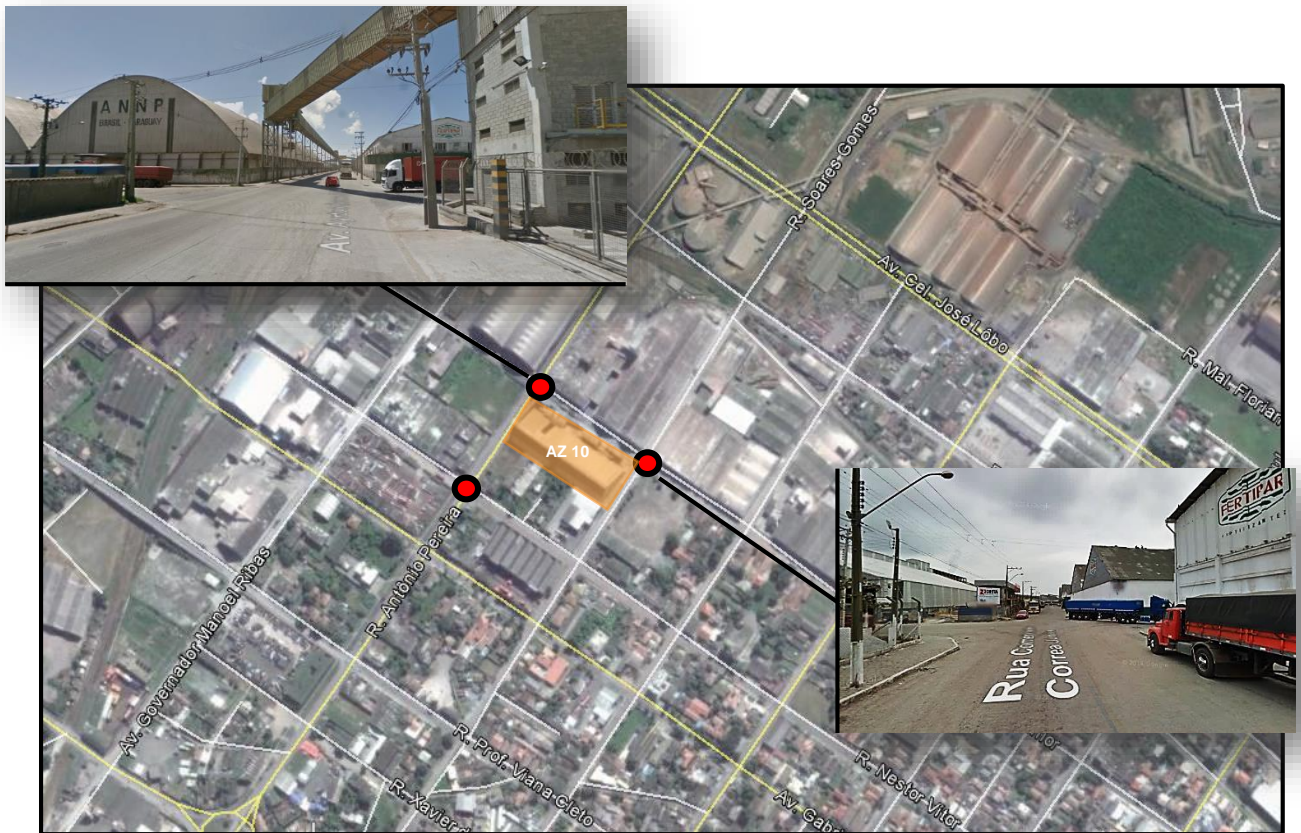
Figura 85. Áreas críticas do empreendimento Armazém 10
