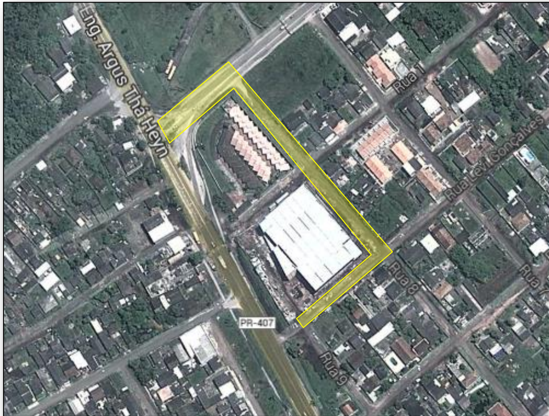
Figura 17. Área crítica do empreendimento
