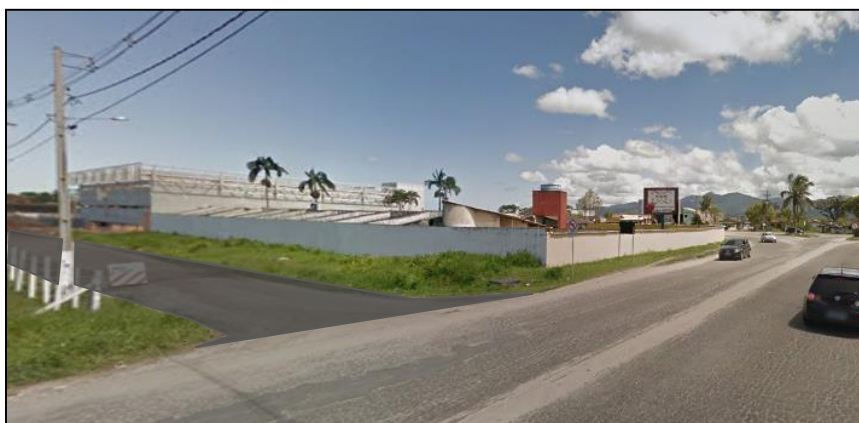
Figura 24. Acesso Rua Osni José Miranda
