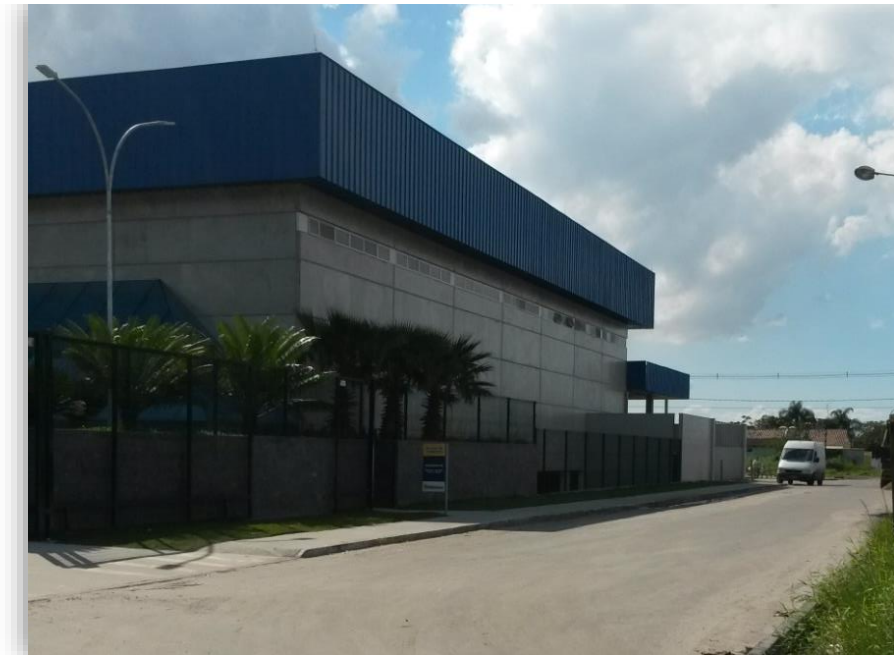
Figura 33. Falta de calçadas
